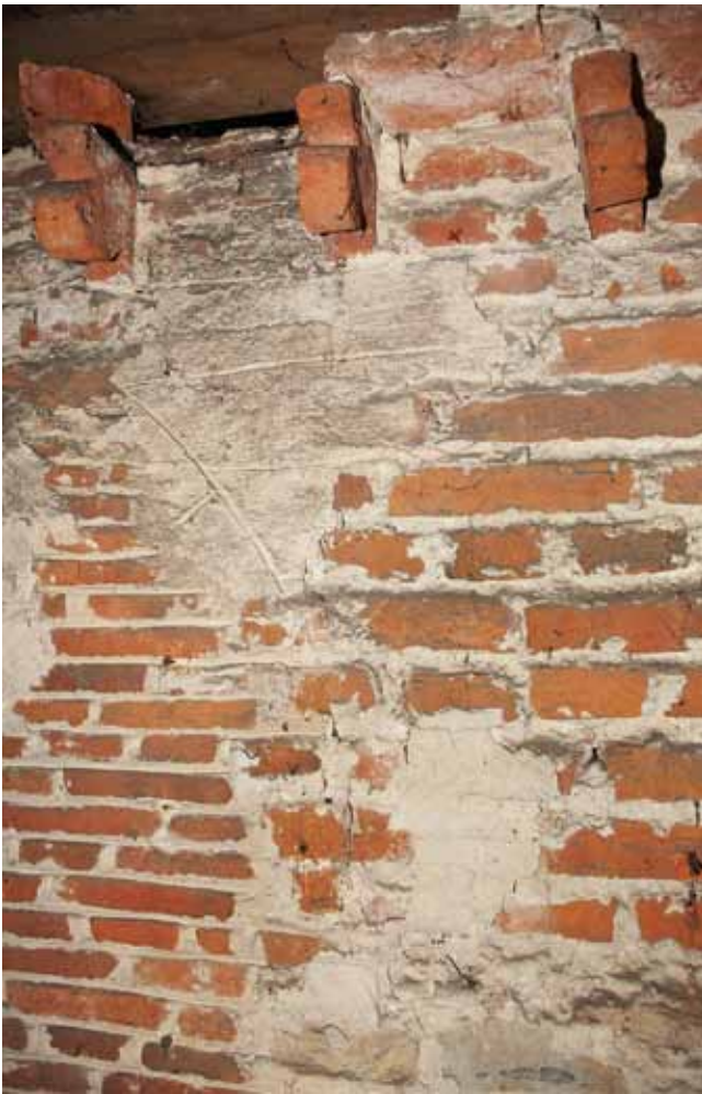
FIG. 13 Resten van de oorspronkelijke afwerking van de noordelijke langsmuur van het middenschip: wit pleister met ingesneden imitatievoegen.
