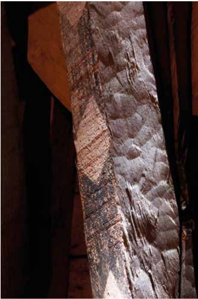
FIG. 10 Keper in de dakkap van het koor met bewerkingsporen van een raamzaag en dissel.
