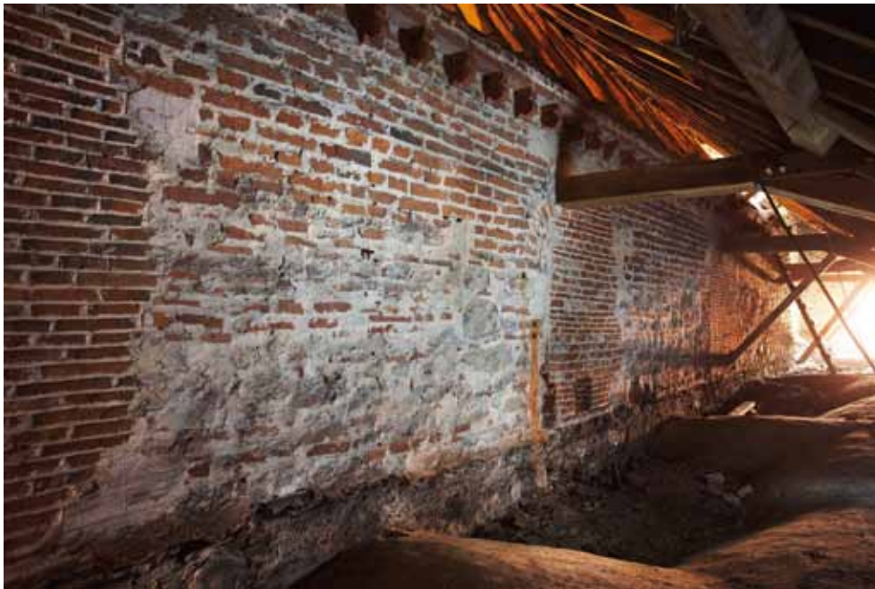
FIG. 11 De noordelijke langsmuur van het middenschip gezien naar het westen, van op het gewelf van de noordelijke zijbeuk. The northern longitudinal wall of the middle aisle looking west, seen from the vault of the northern side aisle.
