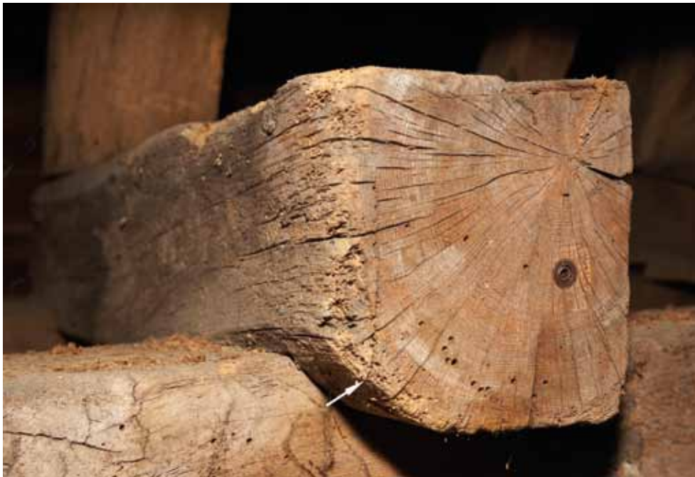
FIG. 8 Blokkeel gezaagd uit een kwart van een stam. Nog slechts enkele spinthoutringen zijn aanwezig (witte pijl). Sole piece sawn from a quarter of a stem. Only a few sapwood rings are preserved (white arrow).
