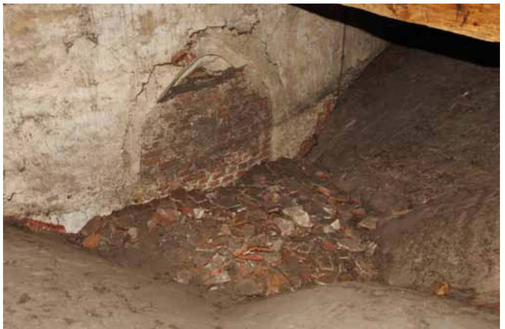
FIG. 4 Gedicht venster van het middenschip, gezien van op het gewelf van het middenschip. Voor het venster liggen brokstukken van daktegels van een van de eerdere bedakingen van de kerk.
