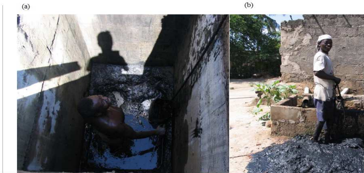
Figure 15 : Vidange manuelle d'une fosse à Dar es Salam: (a) homme se trouvant dans la fosse (b) à l'extérieur de la fosse un autre déverse les boues dans la cour de la parcelle (Sugden, 2005)
