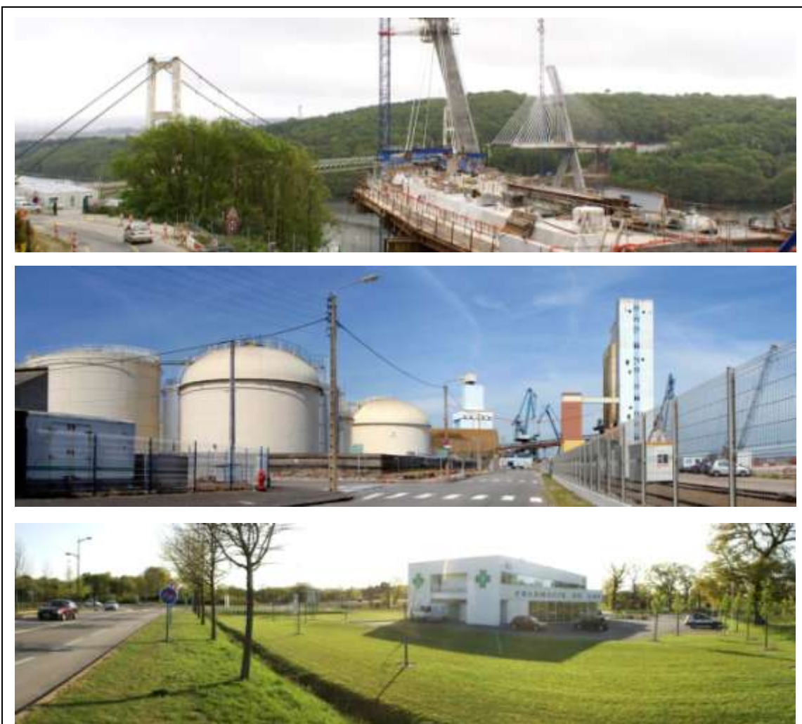
Photo du haut : construction du nouveau pont de Térénez (Finistère) - Photo du centre : zone portuaire et industrielle de Lorient (Morbihan) - Photo du bas : parc d'activités à Saint-Avé (Morbihan).
