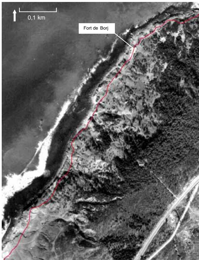
Figure 10. Photographie de 1981 de la zone à falaise de Borj. En rouge, le trait de côte de 1997. Le taux de recul de la falaise est de 1,5 m/an. Aerial photograph (1981) of the Borj cliff. In red, the 1997 coastline. The cliff's rate of retreat is about 1,5 m / year.
