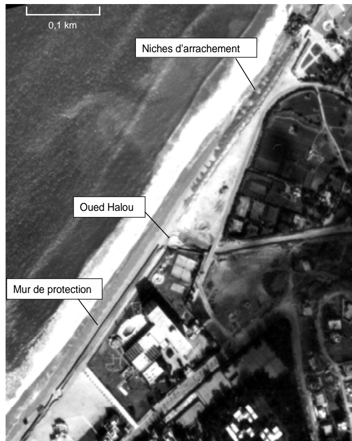
Figure 4. Photographie aérienne de 1981. Forte érosion : niches d'arrachements de la plage de Ghandouri. Aerial photograph of 1981. Strong erosion: erosion scars of the beach at Ghandouri.
