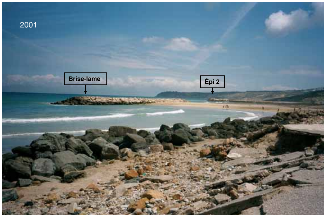
Figure 3. Vue partielle du système de défense installé en 1986. On remarque la formation d'un tombolo derrière le brise-lame. Partial view of the system of defence installed in 1986. Note the formation of a tombolo behind the breakwater.
