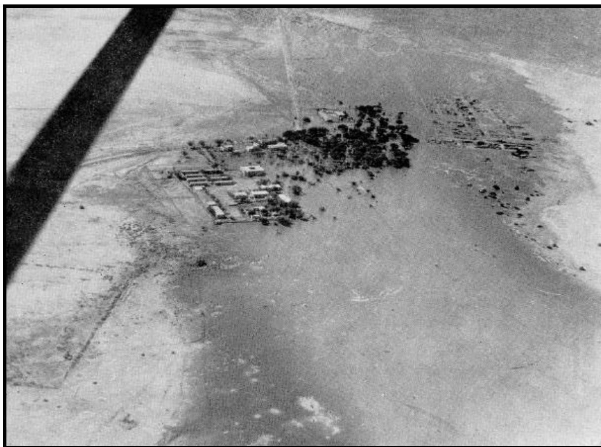
Photo II. 6 : Photographie aérienne du « poste » de Nouakchott le 6 janvier 1951 (DUCHEMIN 1951). Moins de cinquante années plus tard, ce « village » abrite plus d'un million d'habitants.
