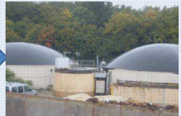
Installations Faascht - Beckerich
