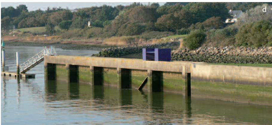
Exemples de passes estuariennes. (a) et (b) Passe à poissons à l'intérieur de la buse estuarienne de la Durdent, (c) et (d) passe piège à anguilles au barrage d'Arzal sur la Vilaine.
