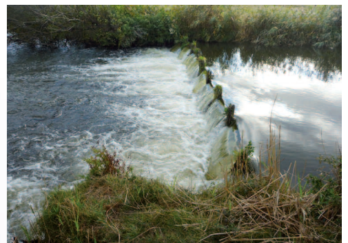
Type de jets et conditions de franchissement d'espèces non sauteuses au niveau d'un obstacle vertical ou quasi vertical (pente >150 %). (a) jet de surface, (b) jet quasi de surface, (c) jet plongeant (chute).
