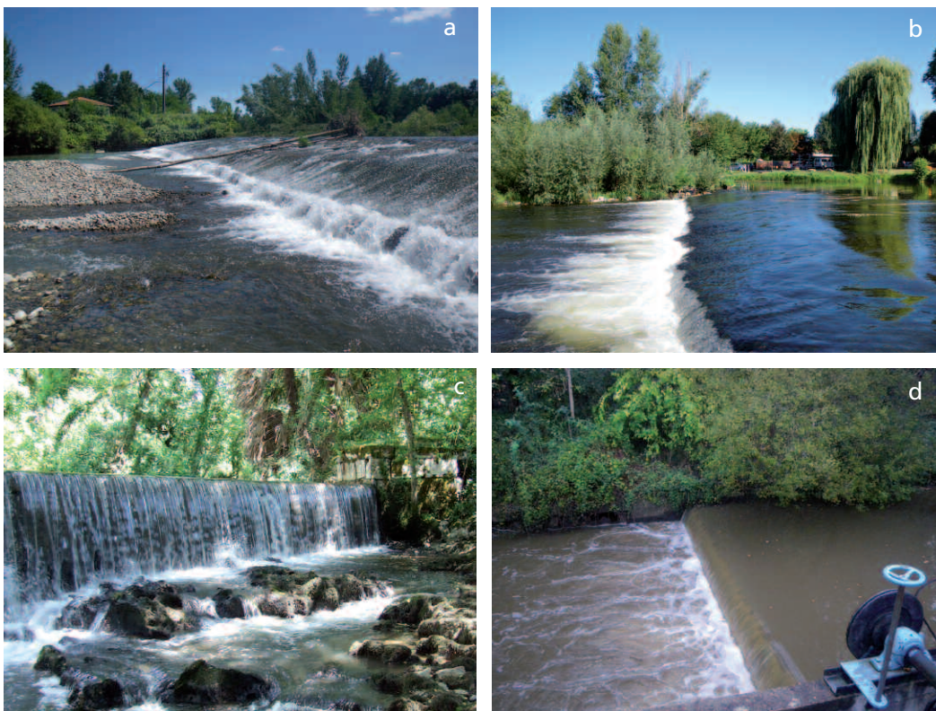
Exemples de fosses en aval d'ouvrages. (a) et (c) Fosses insuffisantes, (b) et (d) fosses suffisantes.
