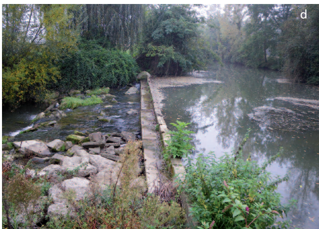
(c) (d) Exemples d'enrochements protégeant les fondations d'un seuil des forces érosives.
