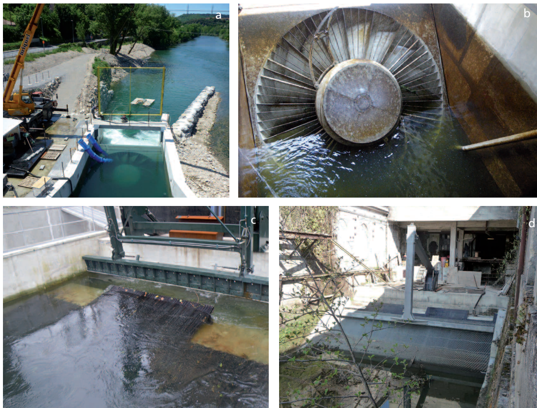
(a, b) Exemple de groupe turbogénérateur possédant des caractéristiques ichtyophiles, (c, d) prise d'eau dite ichtyocompatible (grille inclinée longitudinalement présentant des barreaux à faibles espacements et des exutoires de dévalaison en surface).
