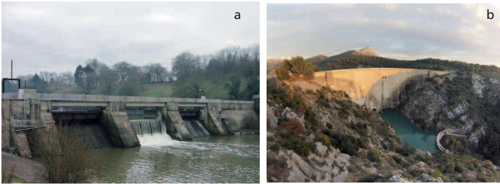
(a) Exemple de barrage poids (Barrage d'Eau Potable d'Apremont), (b) exemple de barrage voûte (barrage de Bimont dans les Bouches-du-Rhône, 87 mètres de hauteur).
