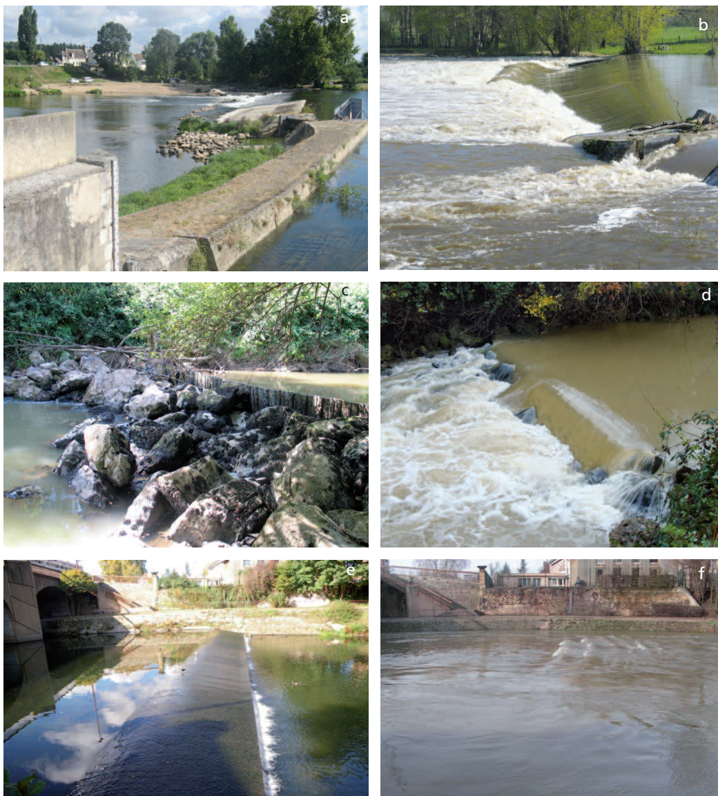
Exemples d'ouvrages à différentes conditions de débit. A gauche (a) (c) (e) basses eaux. A droite (b) (d) (f) hautes eaux.
