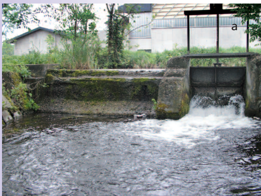
Shémas et exemples de vannes en charge et non en charge. (a) Photo d'un écoulement sous vanne en charge, (b) Photo d'un écoulement au niveau d'une vanne qui n'est pas en charge.
