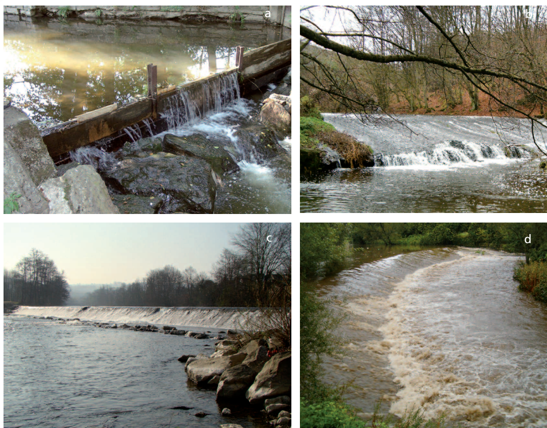
Exemples d'obstacles franchis par des truites communes radio-pistées dans le Sud de la Belgique. (a) L'Aisne, (b) La Lhomme, (c) l'Ourthe, (d) la Vesdre. Les photos a et b sont présentées ici à l'étiage. Les photos c et d ont été prises en conditions hydrologiques de franchissement.
