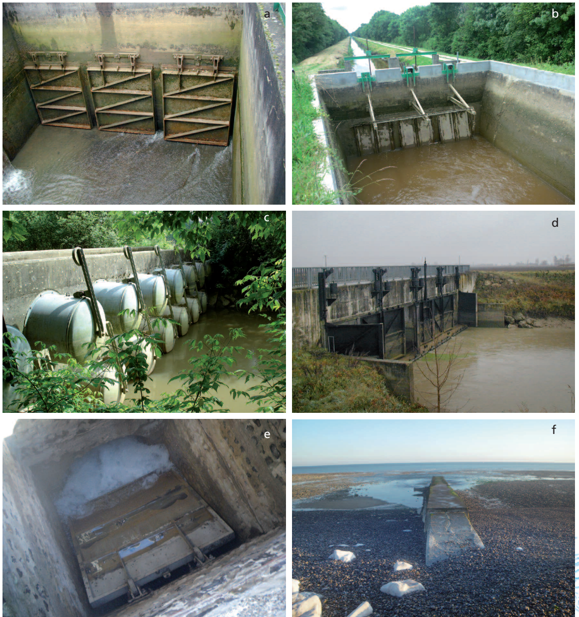
Exemples de clapets à marées. (a) et (b) Clapets mobiles installés dans le Médoc, (c) " Orgues de Staline " installées sur le ruisseau de l'Arroudet, (d) ouvrage composé de portes à flots et de clapets en partie basse (ouvrage situé sur la Jale de Castelnaud), (e et f) ouvrage estuarien situé sur l'Yères composé d'une buse de grande longueur en aval (photos de droite) et d'un clapet en amont (photo de gauche).
