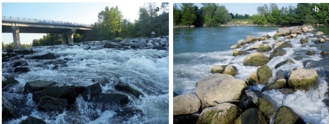
Exemples d'écoulements sur des seuils en enrochements.
