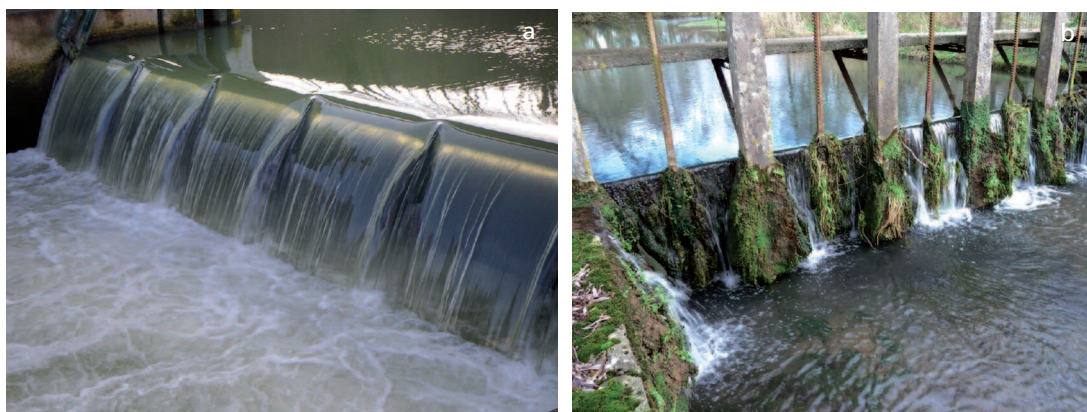
Photos d'écoulements au-dessus d'organes mobiles. (a) Seuil constitué d'un clapet déversant. (b) Ouvrage constitué d'une série de vannages.
