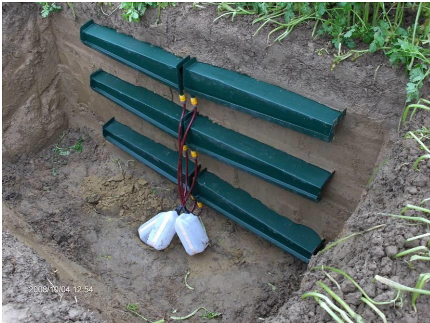
Figure 2-11 : Mise en place des gouttières et bidons de récoltes des flux horizontaux. (Crédit : Stéphane Becquevort)
