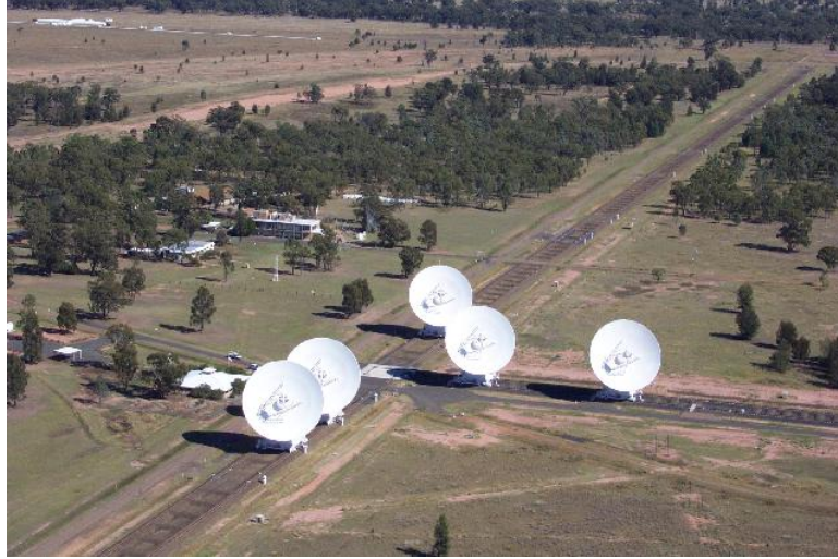
FIGURE 3.3: Photographie de cinq des six antennes d'ATCA, dont trois sur le rail principal et deux sur le rail orienté vers le nord
