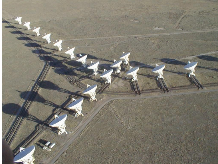
FIGURE 3.2: Photographie de 18 des 27 antennes du VLA
