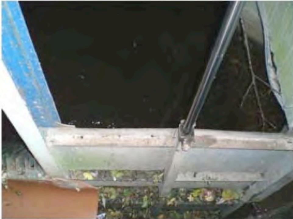
Vannes à côté du dégrilleur qui est seulement ouverte lors du nettoyage de la grille
