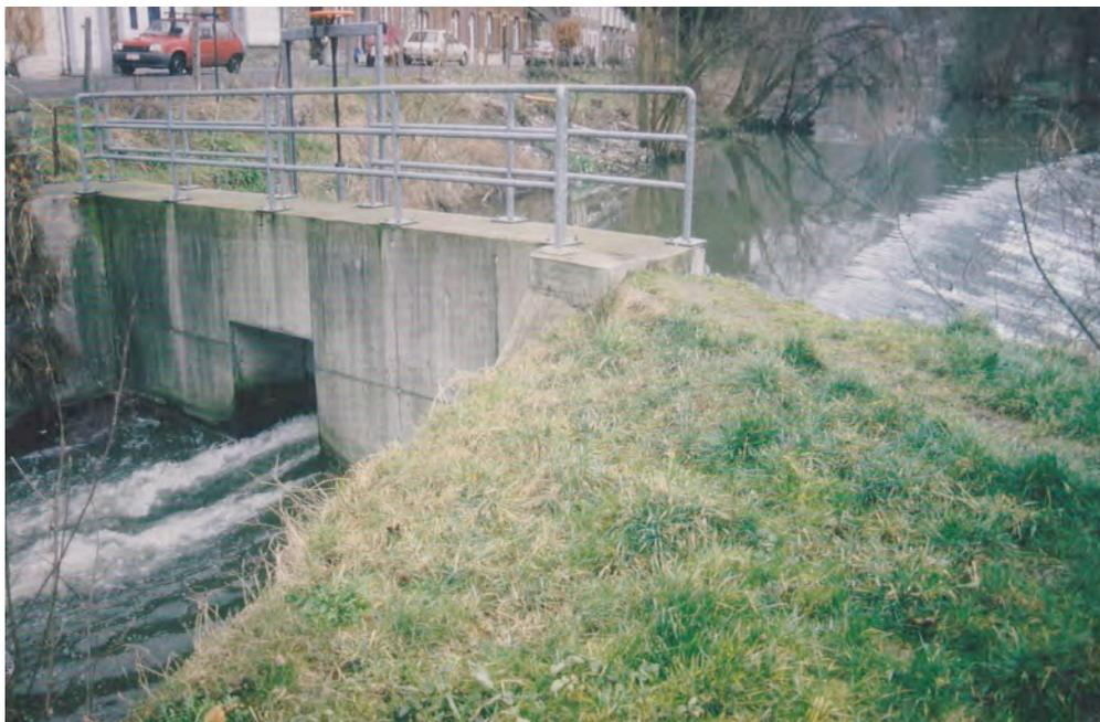
Figure 75. Entrée du canal de prise d'eau contrôlée par une vanne qui entraîne un écoulement de fond. Au-dessus : vue de l'extérieur. En-dessous : vue de l'intérieur
