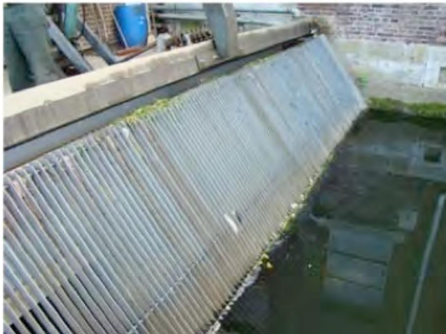
Figure 58 a. Fin du canal d'amenée avec dans le fond la grille à l'entrée de la zone de turbinage et latéralement la vanne de vidange qui débouche dans un petit chenal d'évacuation.
