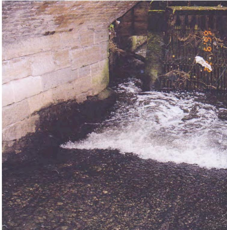
Figure 77. Vue du canal de décharge avec la vanne levée et le bief à niveau fortement abaissé.
