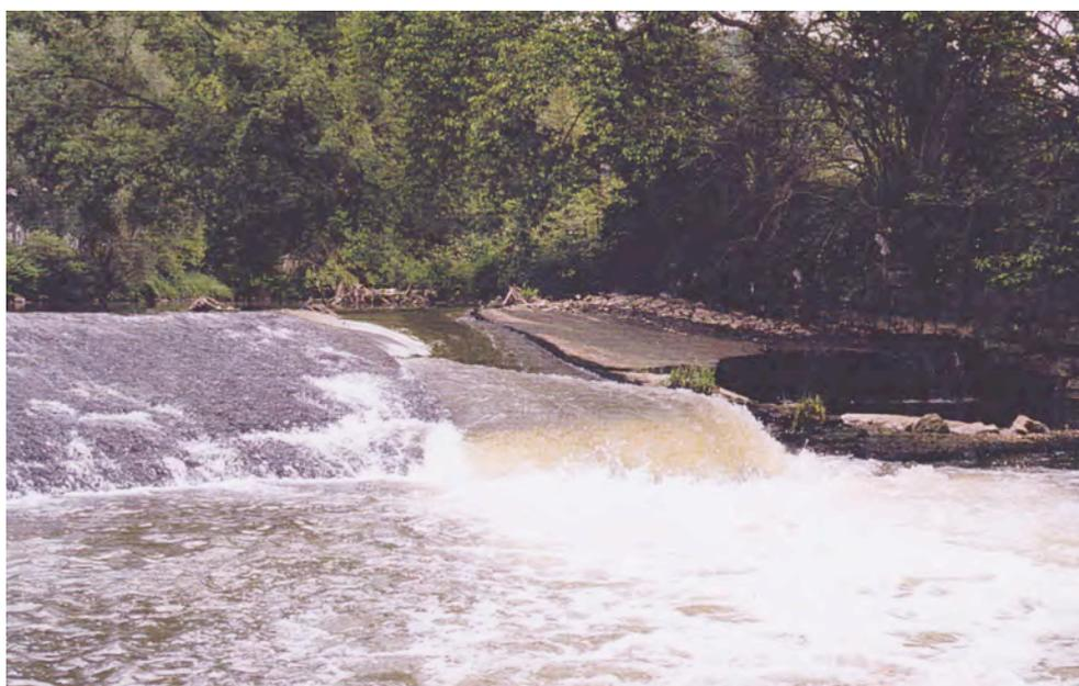
Figure 74. Le barrage de prise d'eau de la CHE du Moulin Pirard à Nessonvaux en début mai 2008 (au-dessus) avec (en-dessous) une vue (22 septembre 1999) sur l'échancrure en rive gauche qui permet l'écoulement d'un débit réservé de 700 l/s et génère une veine d'eau constituant une voie de passage préférentiel pour certains poissons en migration de remontée.
