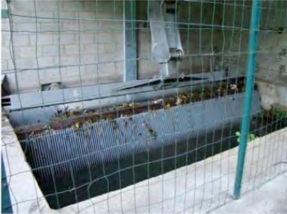
Figure 103. La grille devant la turbine et son dégrilleur.
