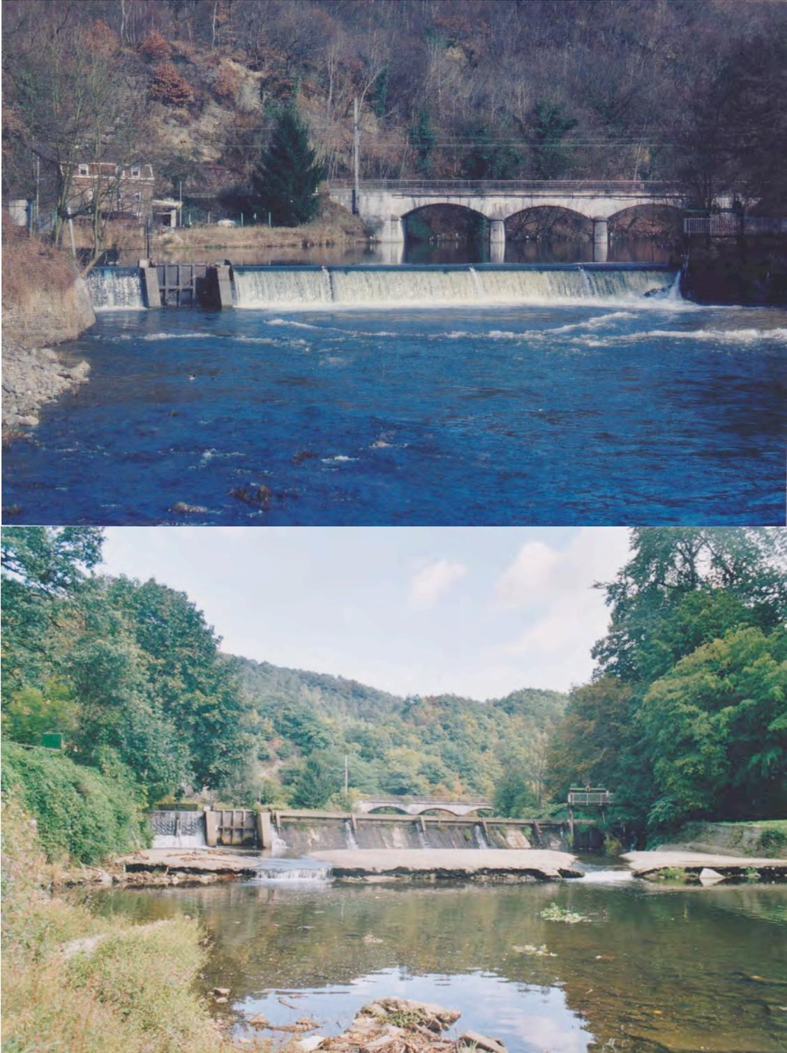
Figure 99. Le barrage de prise d'eau de la CHE de la Fenderie à Trooz dans deux configurations hydrauliques contrastées : au dessus : clapets abaissés et écoulement substantiel par le déversoir et, en-dessous : clapets relevés et écoulement d'un débit réservé au niveau du pertuis de rive droite.
