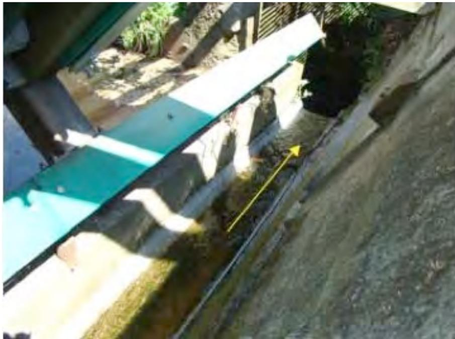
Figure 49. Goulotte d'évacuation des déchets de dégrillage vers le canal de fuite.
