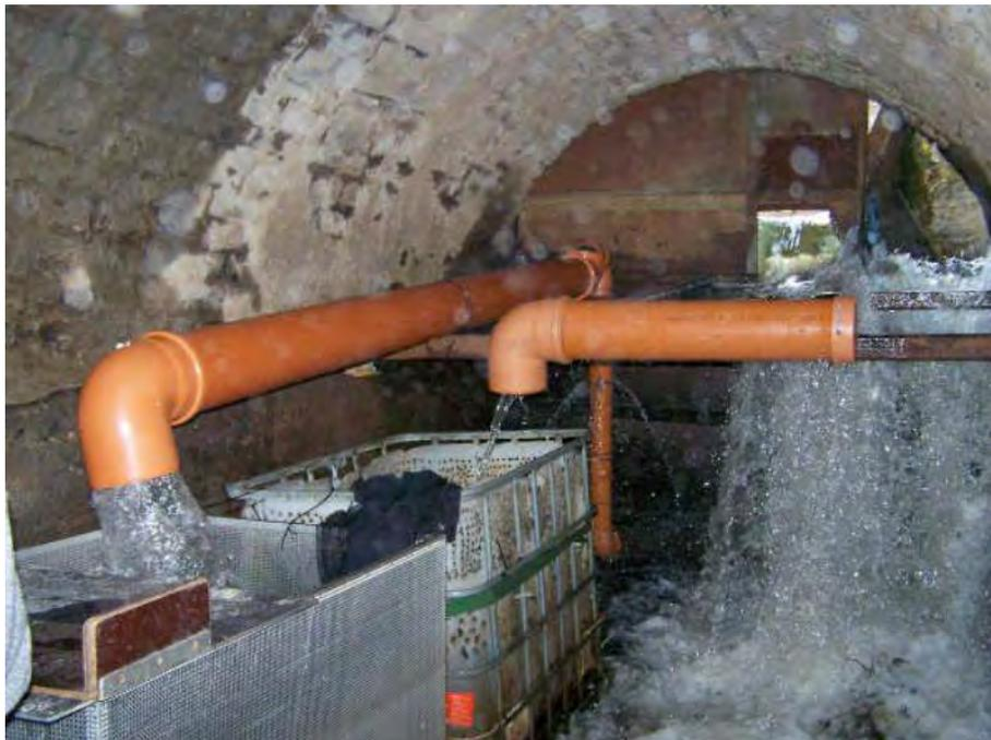
Figure 26b. L'installation de récupération dans des viviers des poissons qui passent par l'exutoire de surface (grille à droite) et par l'exutoire de fond (siphon à gauche) installé en fin
