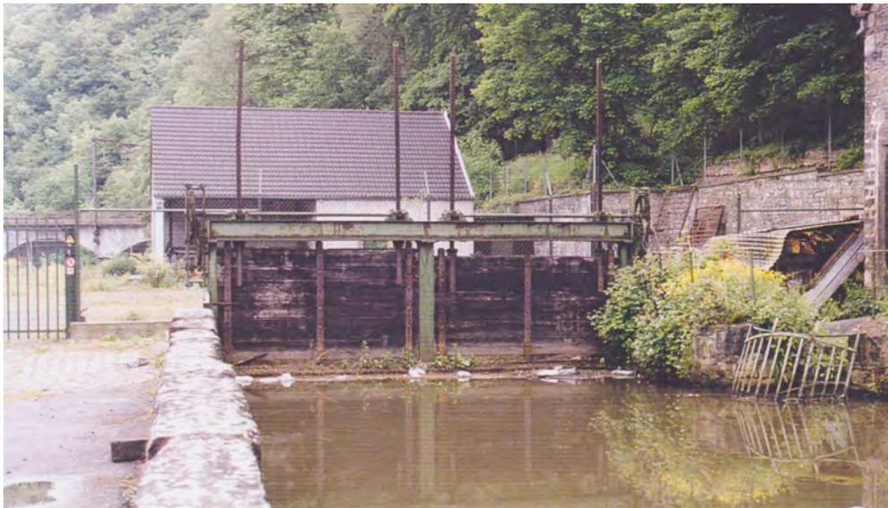
Figure 102. Fin du canal d'amenée (au-dessus) avec (en-dessous) la grande vanne de régulation du débit arrivant à l'espace grille-turbine.
