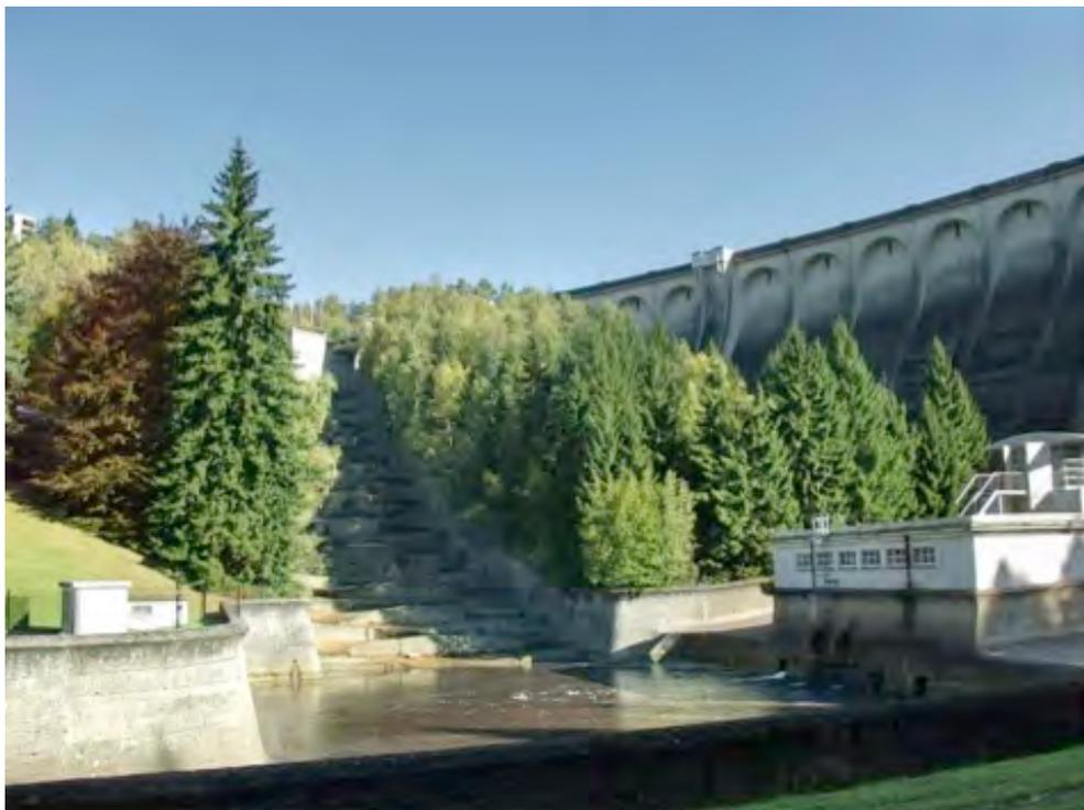
Figure 33. Vue du barrage de la Vesdre et (en-dessous) de l'exutoire de crue (source : Internet)
