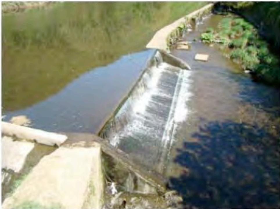
Figure 64. Le barrage de prise d'eau de la CH Gamby à Olne en début mai 2008 constitué (au-dessus) d'un seuil transversal comprenant une partie fixe et une partie mobile et (en-dessous) d'un seuil oblique vers la berge amont gauche et pourvu d'une échancrure peu profonde.
