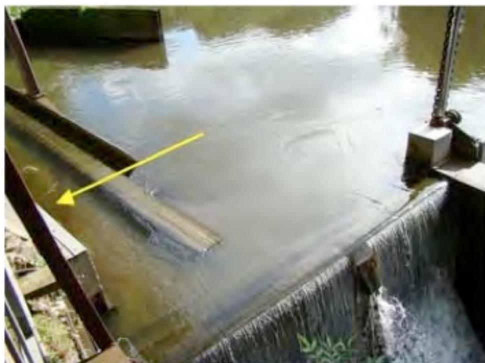
Figure 101. Barrage de la Fenderie sur la Vesdre à Trooz. Au-dessus : vue de la crête de l'ouvrage avec les clapets mobiles en position relevée en période d'étiage. En-dessous : vue du pertuis d'écoulement du débit réservé de 700 l/s et, indiqué par la flèche jaune, de l'entrée du canal d'amenée protégée par une grille pourvue d'un dégrilleur.
