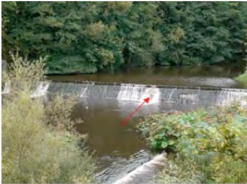
Figure 39 Le barrage de prise d'eau pourvu (flèche) d'un tuyau censé laisser passer un débit réservé de 100 l/s.
