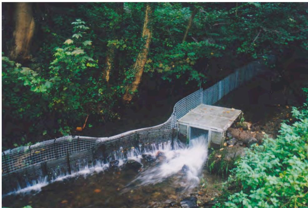
Figure 107. Le piège de capture des poissons (truites communes) en remontée depuis la Vesdre en aval du barrage de la Fenderie à Trooz.
