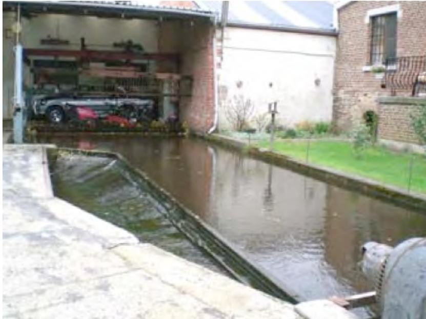
Figure 40. Fin du canal d'amenée avec dans le fond la grille à l'entrée de la zone de turbinage et à gauche, le dispositif d'évacuation des déchets flottants (avant-plan) et la vanne de vidange du bief (arrière-plan).
