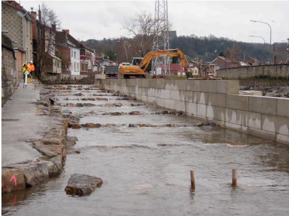
Figure 109. Etat d'avancement en fin décembre 2013 de la construction de la nouvelle échelle à poissons aménagée sur le barrage de Lhonneux sur la Vesdre à Chênée (source : Direction des Cours d'Eau Non Navigables du SPW)
