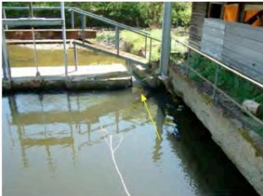
Figure 65. Partie terminale du canal d'amenée montrant à droite de l'image du dessous l'écoulement longitudinal vers la grille à l'entrée de la zone de turbinage et, dans le fond de l'image, à côté d'une grande vanne de vidange du bief, une petite échancrure pseudo-exutoire permanent qui se prolonge un chenal d'évacuation qui débouche en chute dans la Vesdre court-circuitée.
