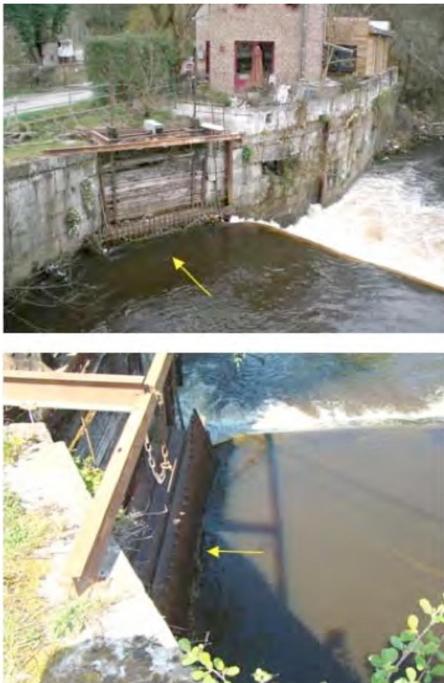
Figure 47 Vues en début mai 2008 de l'entrée de la prise d'eau située latéralement juste à l'amont du seuil et pourvue d'une première grille avec un espace interbarreaux estimé à une dizaine de cm.
