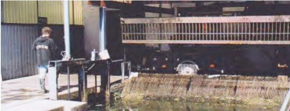
Figure 42. Possibilité d'aménager un exutoire de dévalaison des poissons au niveau de la vanne situé dans le prolongement du plan de grille à barreaux espacés de 2 cm.
