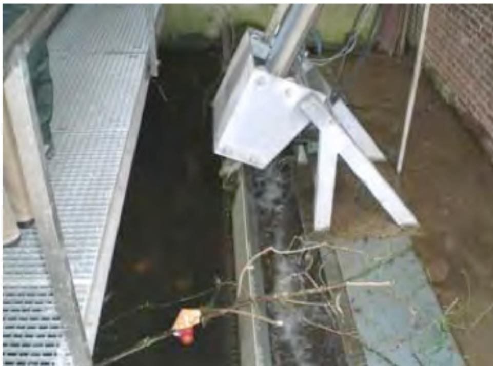
Figure 91. La grille à barreaux espacés de 4 cm et le dégrilleur automatique ainsi que la goulotte d'évacuation des déchets vers la Vesdre.
