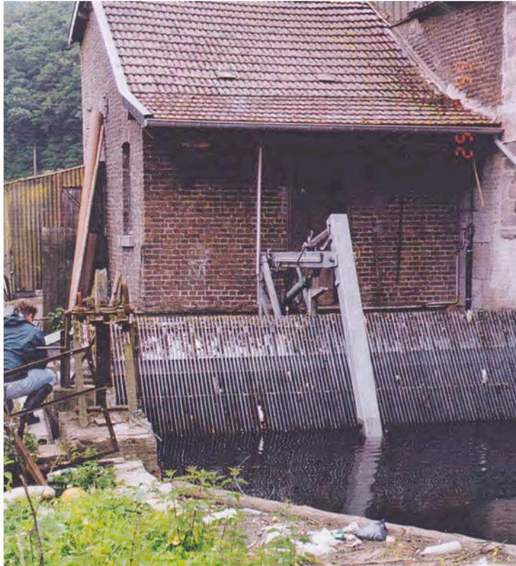
Figure 59 La grille et le dégrilleur automatique de la CHE du moulin de Fisenne sur la Vesdre.
