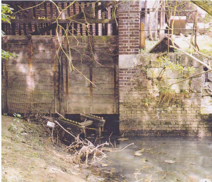
Figure 90. Vue à sec de l'entrée contrôlée par une vanne du canal d'amenée de la CHE De Bioley à Fraipont (photo FS..)
