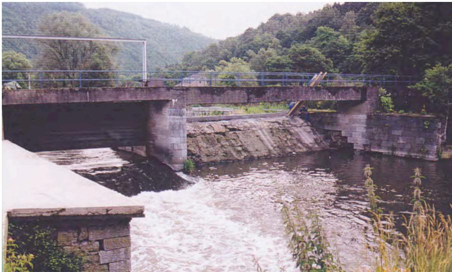
Figure 69. Le barrage de prise d'eau de la CHE Gamby à Olne en position d'ouverture de la vanne mobile qui permet le passage des poissons.
