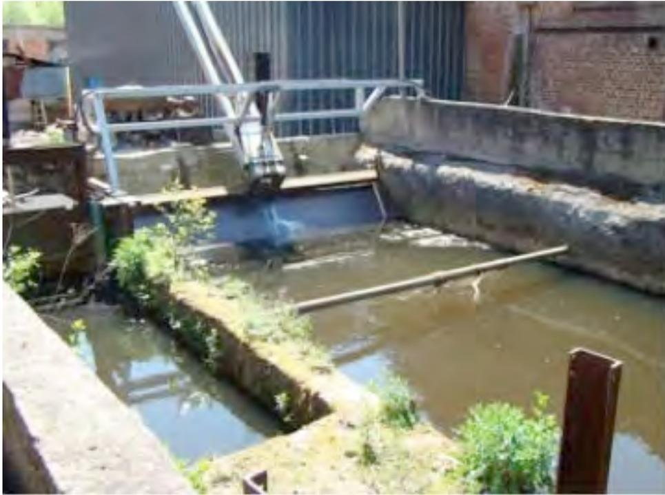
Figure 48. Fin du canal d'amenée avec dans le fond la grille à l'entrée de la zone de turbinage et le bras de dégrillage automatique
