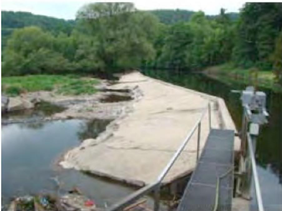
Figure 88. Le barrage de prise d'eau de la CHE de Bioley à Fraipont dans deux configurations contrastées de débit de la Vesdre en début avril 2008 (au-dessus) et pendant l'étiage en début mai (en-dessous). A l'avant plan, on reconnaît la vanne de vidange de la retenue.
