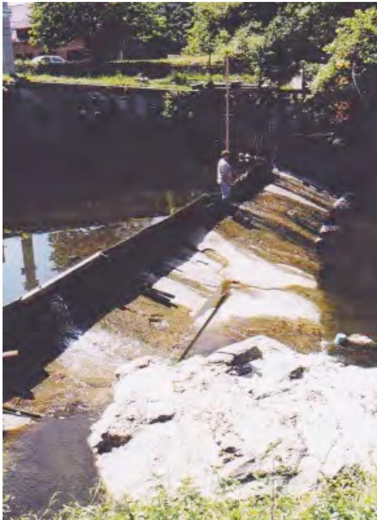
Figure 52. Le barrage de prise d'eau vers la CHE Gamby en condition de faible débit de la Vesdre
