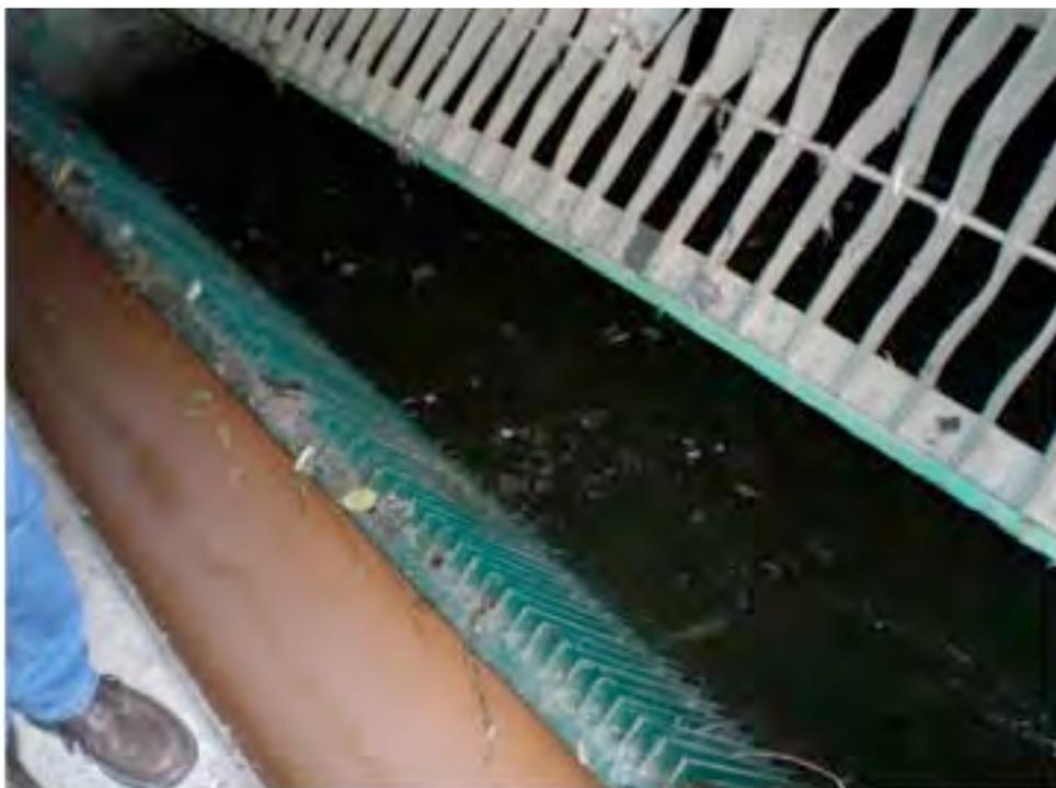
Figure 78 . La grille à barreaux espacés de 4 cm et le dégrilleur automatique ainsi que la goulotte d'évacuation des déchets vers le canal de fuite.
