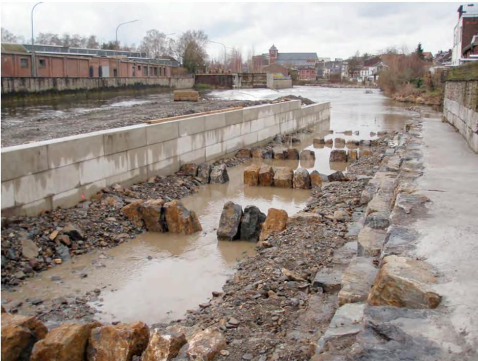
Figure 20. Etat d'avancement en fin décembre 2013 de la construction de la nouvelle échelle à poissons aménagée sur le barrage de Lhoneux sur la Vesdre à Chênée (source : Direction des Cours d'Eau Non Navigables du SPW)
