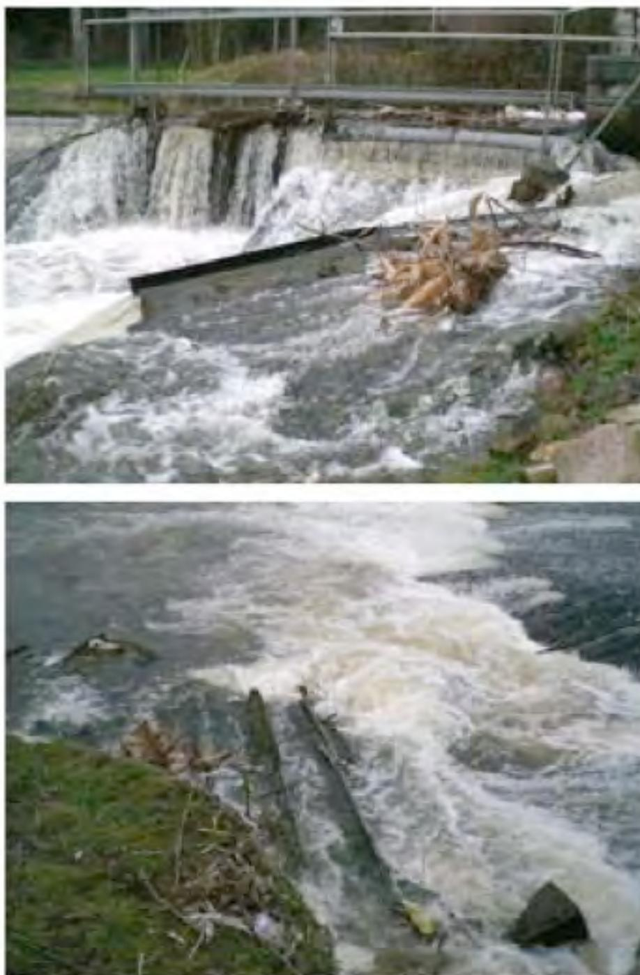
Figure 89. Vue en condition de débit élevé de la berge gauche du seuil de Haute-Fraipont montrant le vanne de vidange de la retenue et l'exutoire à déchets
