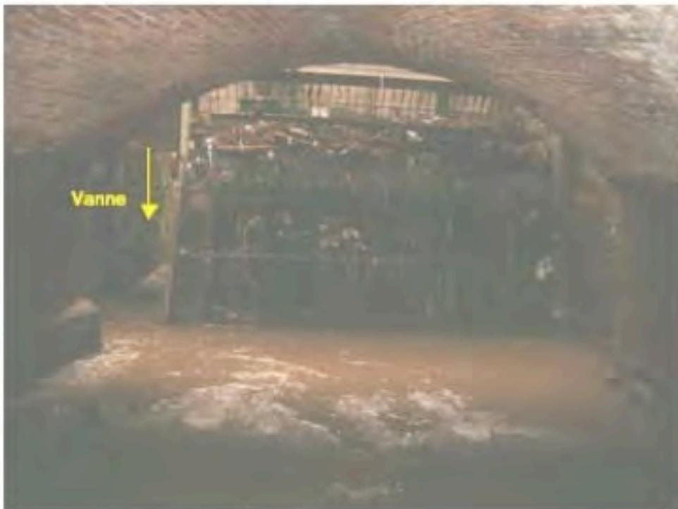
Figure 76. Partie terminale du canal d'amenée avec niveau abaissé montrant (photo du dessus), à droite de l'image, la grille et le dégrilleur et, à gauche, la vanne (photo du dessus) et le canal de décharge qui débouche dans le canal de fuite.
