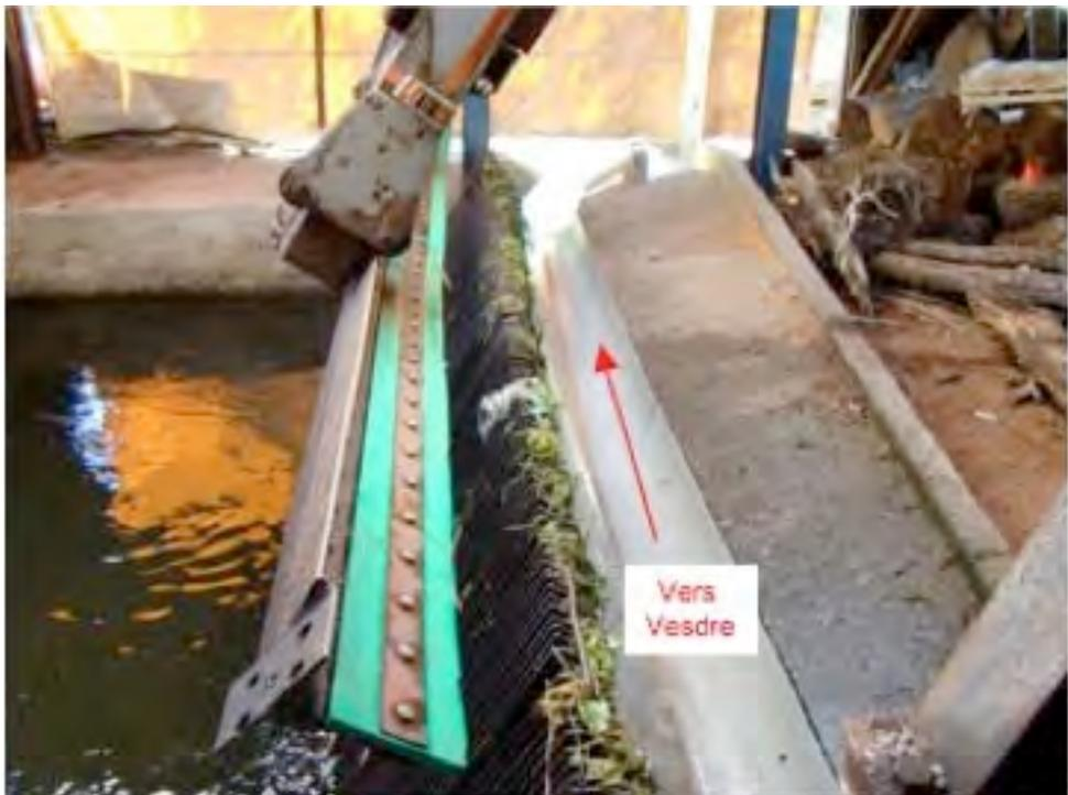
Figure 66 . La grille à barreaux espacés de 3 cm et (en-dessous) le dégrilleur automatique ainsi que la goulotte d'évacuation des déchets vers la Vesdre.
