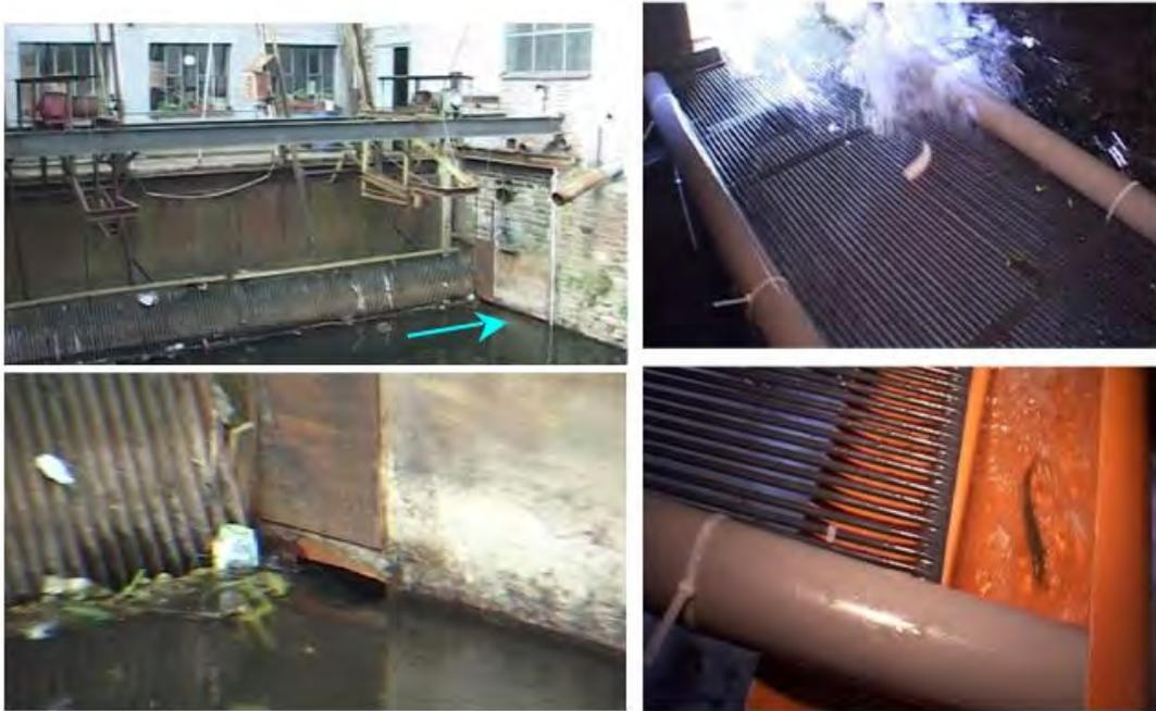
Figure 26a. Vues (à gauche) de l'exutoire de dévalaison latéral (débit : 0,1-0,2 m<sup>3</sup>/s ; vitesse : 1-1,2 m<sup>3</sup>/s) aménagé dans le prolongement latéral de la grille de la prise d'eau de la centrale hydroélectrique Mérytherm (10 m<sup>3</sup>/s maximum) sur l'Ourthe et (à droite) du système de récupération des poissons (extrait du film de présentation de ProFish Technology).
