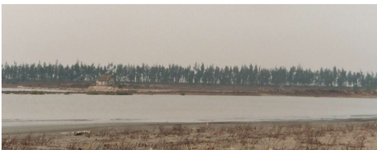
Digue du défluent Song Sô en décembre 2002, en février 2003 et en décembre 2003.
