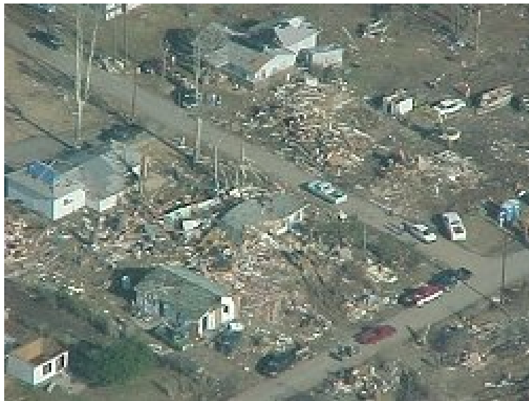
Fig. 19: Dégâts après le passage d'une tornade : remarquez le corridor typique de débris et les maisons épargnées de chaque côté.
