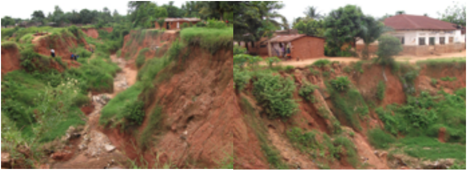
Figures 26, 27 : Erosions à Mbuji-Mayi, au croisement des avenues Tshala Muana et Maman Yemo
