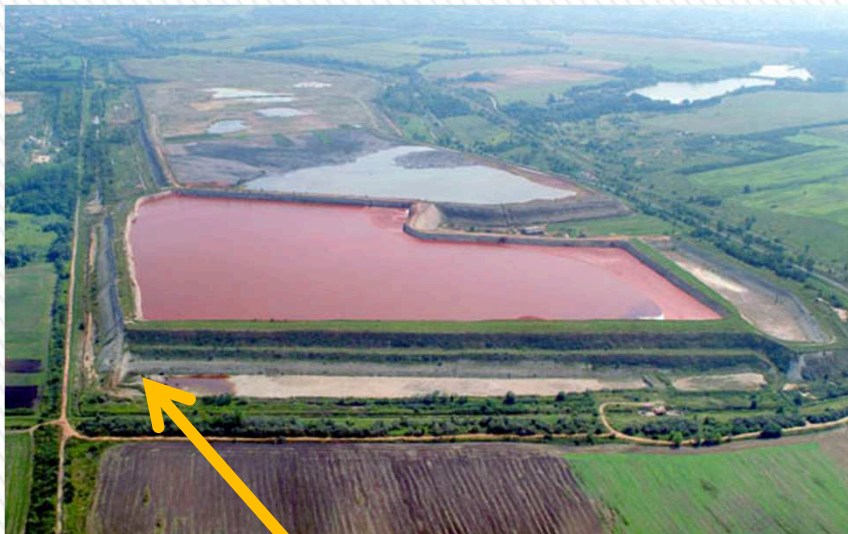
Rupture de digue en Hongrie (Oct, 2010)
