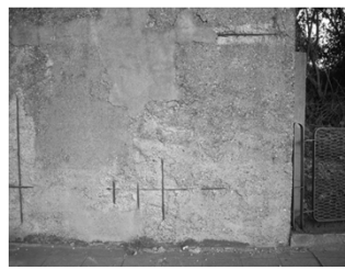
effet de la carbonatation
