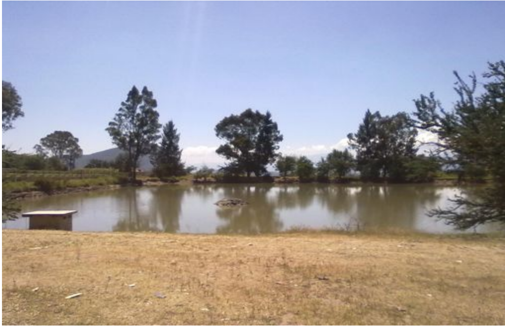
Fotografía 3. Represa construida con el fin de recolectar agua en época de seca, en Progreso Hidalgo
