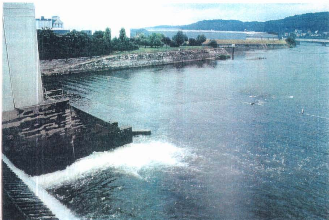
Photo 5. Vue de la zone 1 en aval des déversoirs, peu profonde (radier) et à courant rapide.
