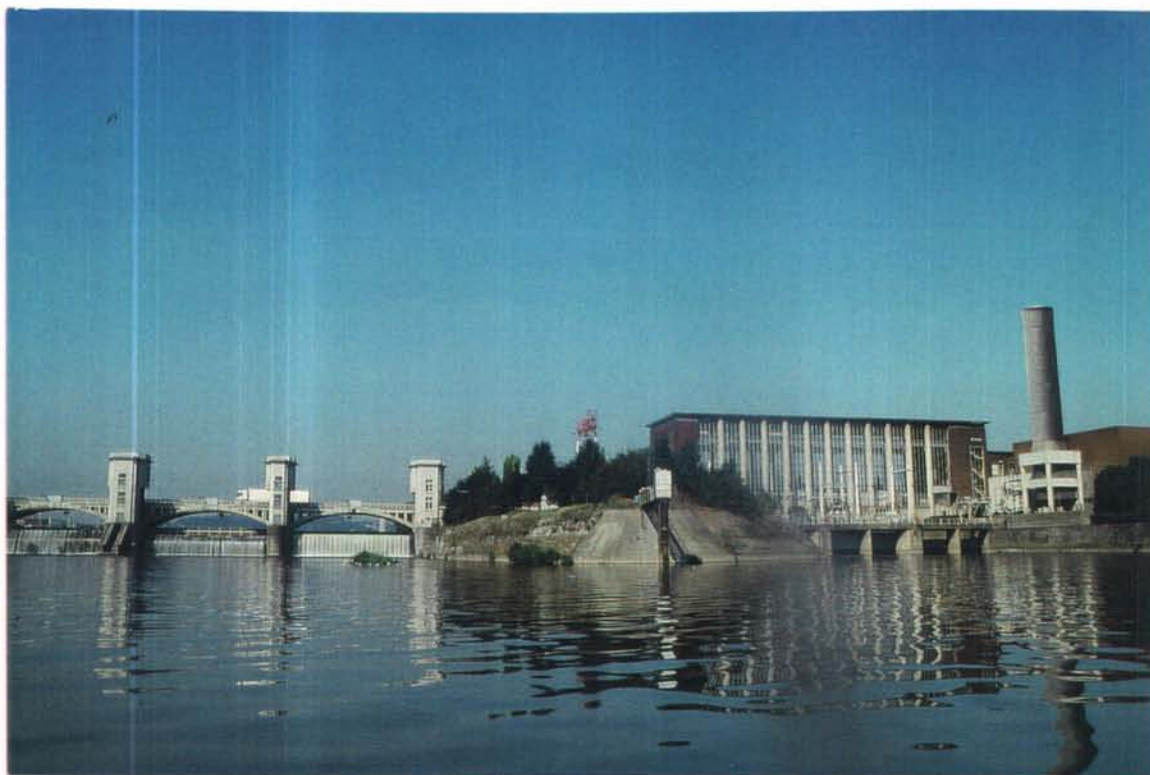
Photo 1. Vue de la Meuse en aval du barrage de Monsin montrant le canal de fuite de la centrale hydro-électrique (à droite) et le cours principal en aval des déversoirs (à gauche) (août 2001).
