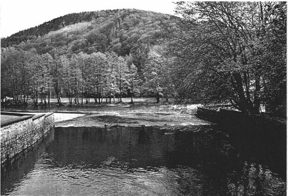
Photos 12 . Le canal de fuite de la microcentrale de la cascade de Coo à la sortie de la turbine (au-dessus) et à l'endroit de la restitution de l'eau dans l'Amblève juste en aval de la cascade (en-dessous).
