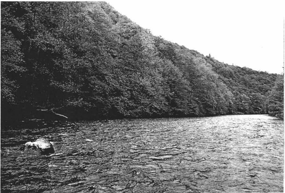
Photo 2 . L'Amblève à Heid de Goreux, dans la zone d'influence du rejet de l'eau turbinée par la centrale hydroélectrique alimentée par la conduite forcée venant du barrage de Lorcé. Mai 2005
