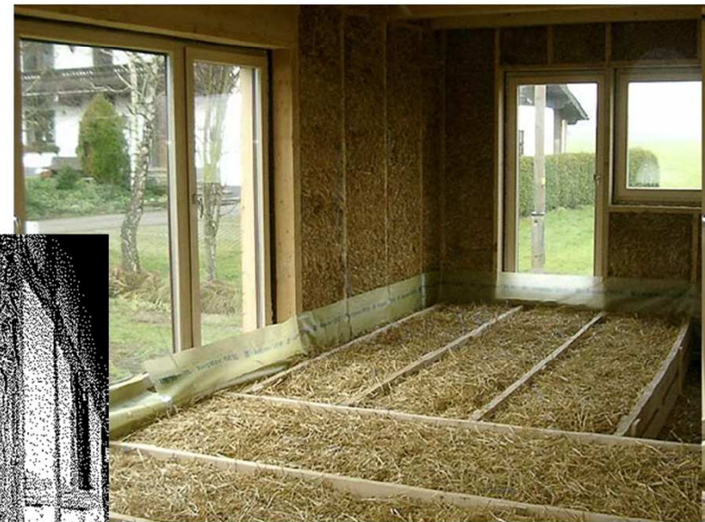
Plancher en terre-paille coulée
