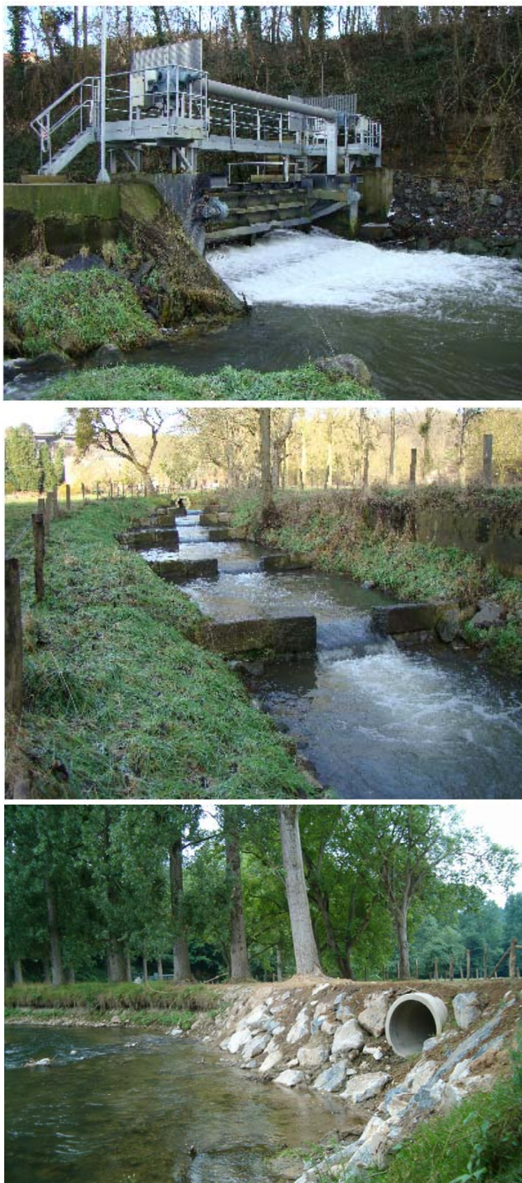
Figure 26. La nouvelle échelle à poissons du barrage de prise d'eau de la CHE Carneuse. Au-dessus : entrée de l'échelle à poissons juste à l'aval du barrage de prise d'eau (en position ouverte). Au milieu : succession des bassins séparés par des petits seuils. En-dessous : sortie amont de l'échelle vue en situation d'abaissement du niveau de la retenue artificielle.
