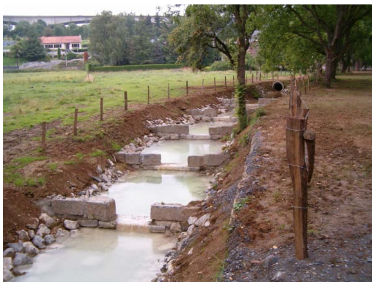
Figure 27. Vue de l'échelle à poissons à bassins de Huccorgne avant sa mise sous eau en début 2008.
