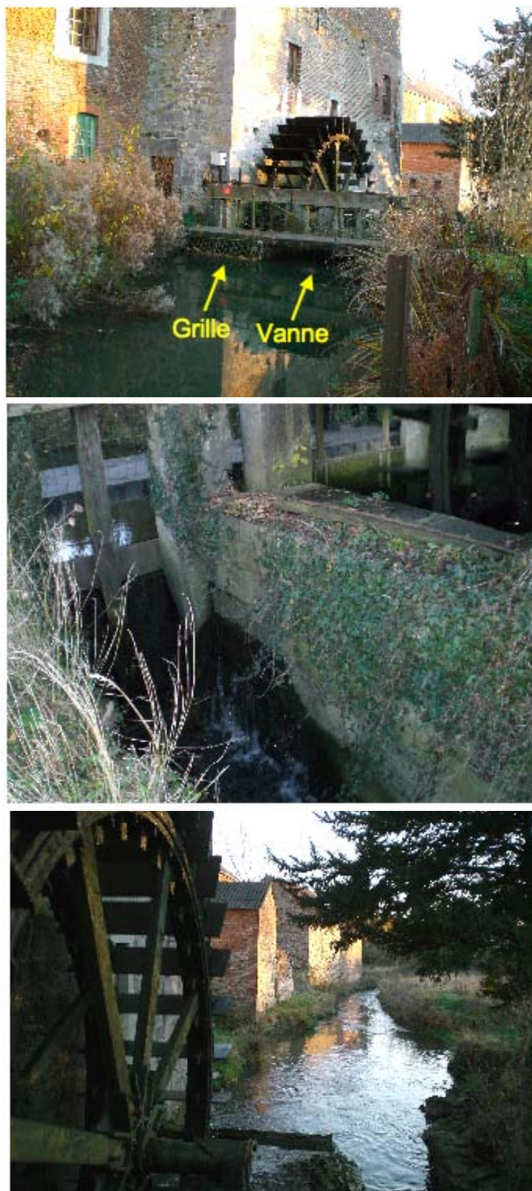
Figure 61. Eléments de la CHE du moulin Heine à Fallais. Au-dessus : vue par l'amont de l'entrée de la roue à aubes protégée par un grillage métallique et de la vanne de vidange du bief exceptionnellement ouverte. Au milieu : vue par l'aval de la vanne de régulation-vidange qui repose sur un petit seuil vertical d'une trentaine de cm. En-dessous : canal de fuite en aval de la roue à aubes.
