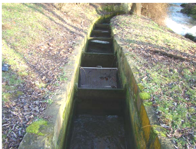
Figure 12. Le barrage de prise d'eau de la CHE à Moha avec la rehausse amovible en place vu par l'aval (au-dessus) et par l'amont (au milieu) et (en-dessous) l'échelle à poissons à bassins + piège de capture aménagée en rive gauche
