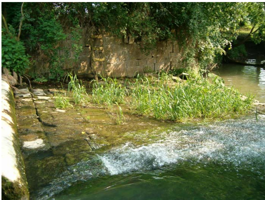
Figure 46. Vue du déversoir de décharge et de crue dans la situation avant l'installation de la vis hydrodynamique montrant la faible pente de l'ouvrage.
