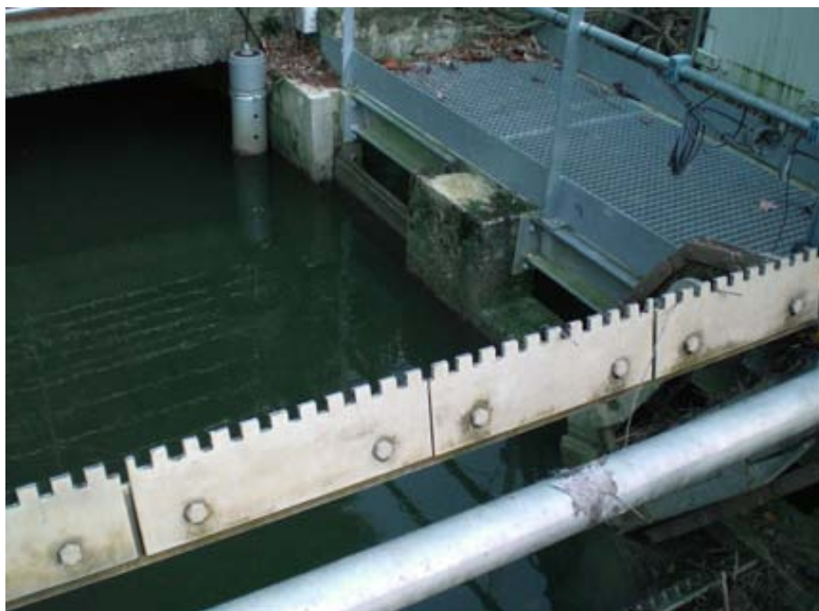
Figure 33 . La zone possible d'aménagement d'un exutoire de dévalaison de surface au niveau du moine en planches de bois qui fait office de déversoir latéral au fond du canal d'amenée près du plan de grille de la CHE de Huccorgne-Carmeuse sur la Méhaigne.
