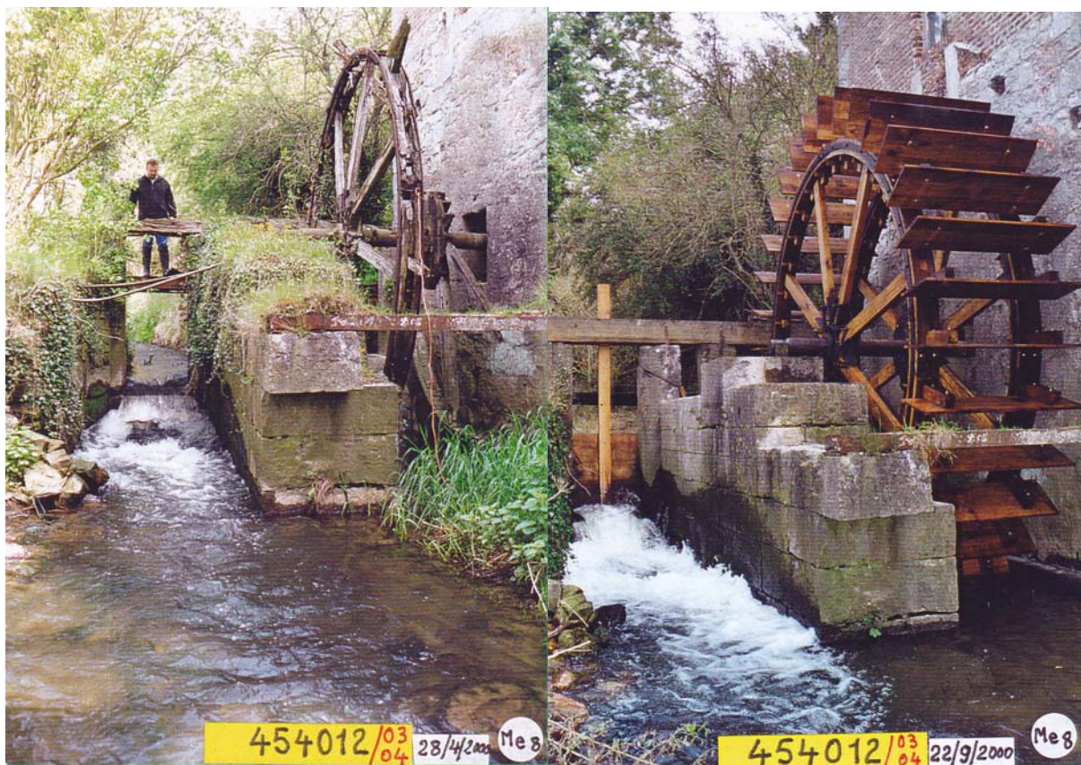
Figure 57. Le site du moulin Heine avant (à gauche) et après (à droite) la rénovation de la roue en 2000 (source : rapport FSPE, 2000)
