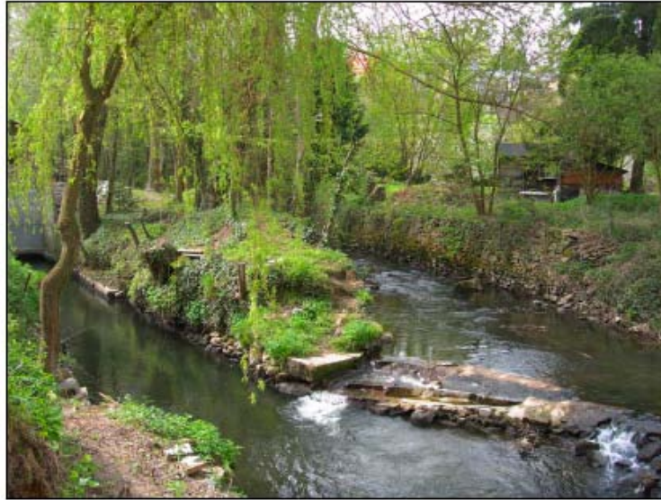
Figure 14. La jonction entre le canal de fuite de la CHE de Moha (bras à gauche de l'image) et le cours naturel de la Méhaigne court-circuité par la prise d'eau (bras à droite de l'image). Dans la zone de confluence existe un seuil perméable aux poissons au niveau de l'échancrure située à la pointe de l'îlot de séparation des deux bras (source : Duchateau et al., 2010).
