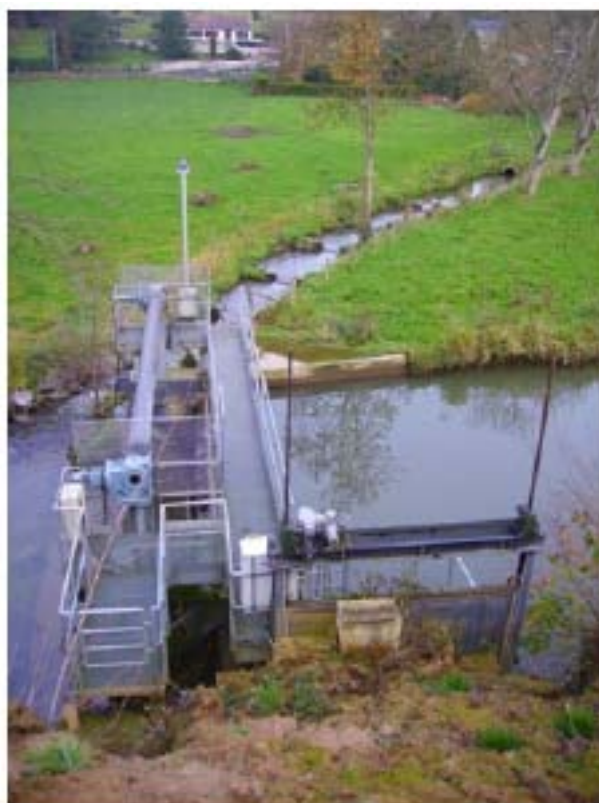
Figure 23. Le barrage de retenue de la CHE Carmeuse sur la Méhaigne à Huccorgne. Au-dessus : vue par l'aval du nouveau barrage avec la vanne en position ouverte permettant le libre écoulement de la Méhaigne. En-dessous : vue du dessus (source : Praillet, 2011) montrant le barrage et le bras de contournement partant de sa base aval droite et faisant office d'échelle à poissons.
