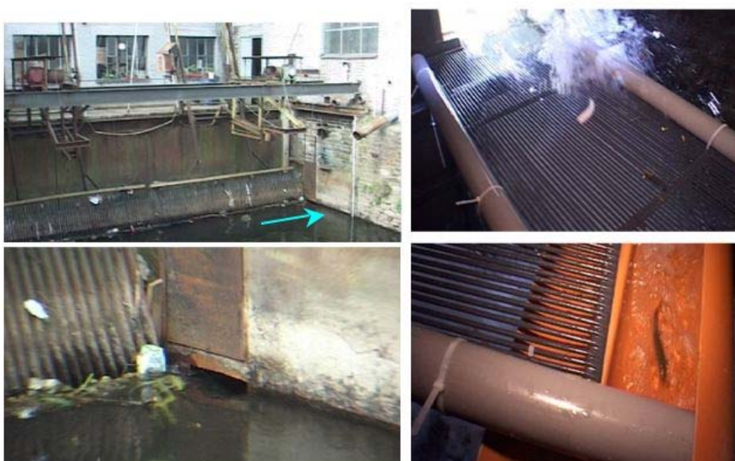
Figure 34 . Vues (à gauche) de l'exutoire de dévalaison latéral (débit : 0,1-0,2 m 3 /s ; vitesse : 1-1,2 m 3 /s) aménagé dans le prolongement latéral de la grille de la prise d'eau de la centrale hydroélectrique Mérytherm (10 m 3 /s maximum) sur l'Ourthe et (à droite) du système de récupération des poissons mis en place pour les besoins du monitoring (extrait du film de présentation de ProFish Technology)(source : Philippart et al., 2010).
