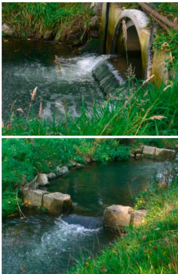
Figure 31. Vue de deux types de petits seuils à franchir par les poissons dans l'échelle à bassins de Huccorgne sur la Méhaigne . En-dessous : seuil entre les bassins intermédiaires. Au-dessus : seuil pour sortir du bassin supérieur en passant dans un tuyau.
