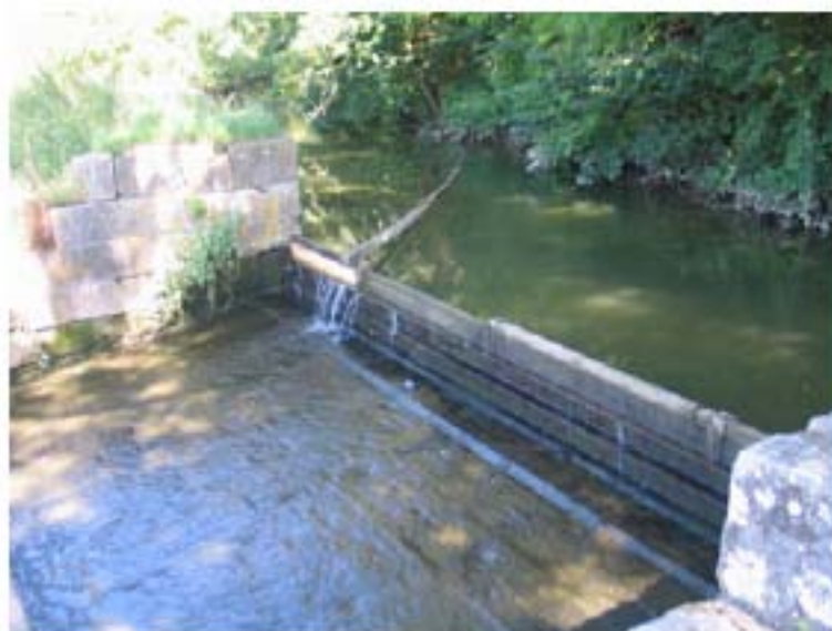
Figure 63. Absence estivale de débit réservé alimentant le tronçon de la Méhaigne court-circuité par la prise d'eau vers la roue hydro-énergétique du moulin Heine à Fallais (source de la photo : Praillet, 2010).
