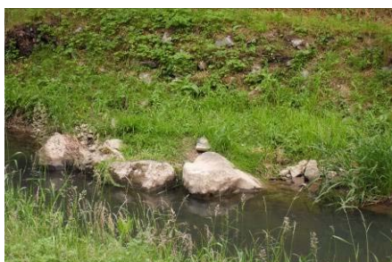
hauteur d'eau de 0,50 m
