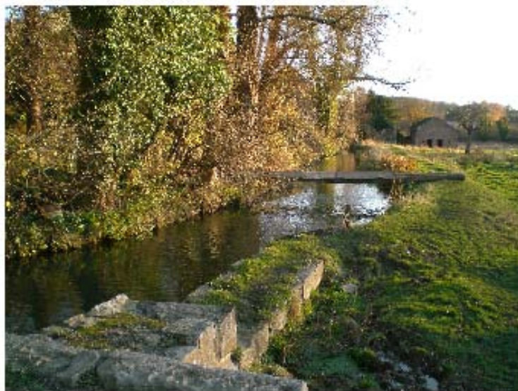
Figure 60. La prise d'eau de la CHE du moulin Heine à Fallais. Au-dessus : barrage de décharge dans le bras court-circuité. Au milieu : débit dirigé vers la roue à aubes et débit réservé dans le bras court-circuité. En-dessous : début du canal d'amenée
