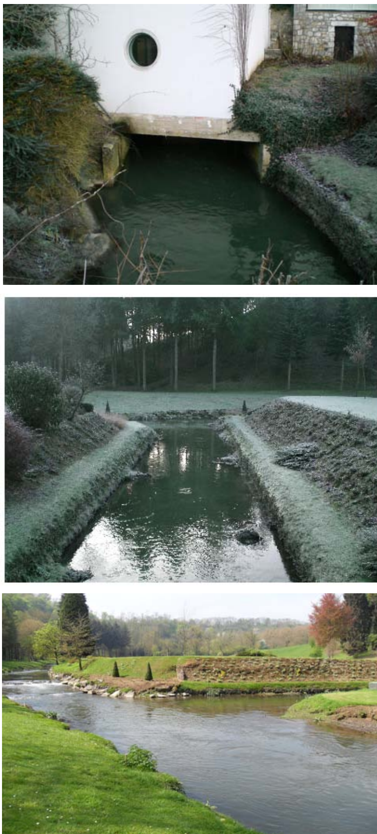
Figure 25. Zone de restitution de l'eau turbinée. Au-dessus : sortie de la turbine. Au milieu : court canal de fuite. En-dessous : confluence entre le canal de fuite et le lit naturel de la Méhaigne (écoulement vers la droite). Photos prise en situation de non turbinage.
