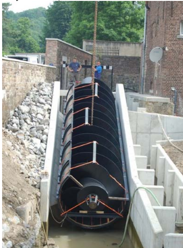
Figure 50 . Vue depuis l'aval de la vis hydrodynamique en voie d'installation au Val Notre-Dame et d'une partie de l'échelle à poissons (source : Journal Vers l'Avenir du 22/06 2012).
