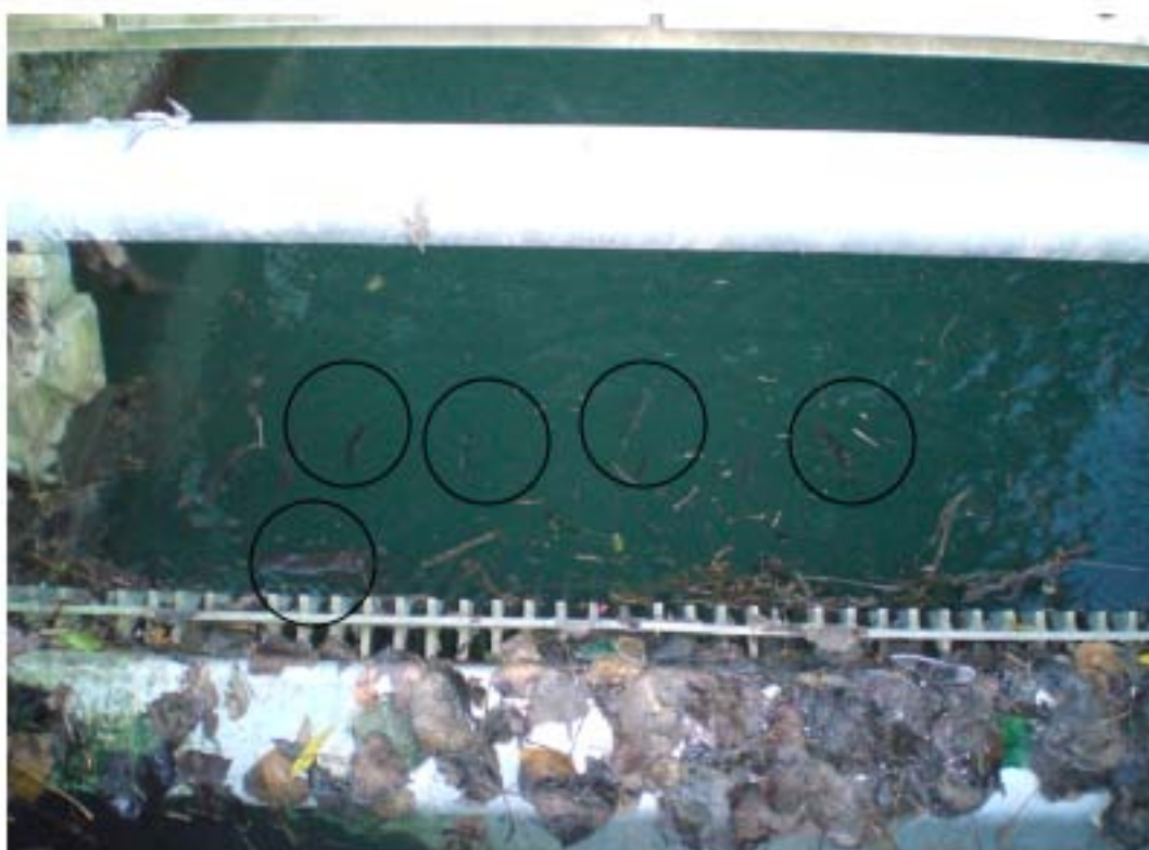
Figure 32. Concentration de poissons devant la grille de protection de la turbine de la CHE Carneuse sur la Méhaigne à Huccorgne
