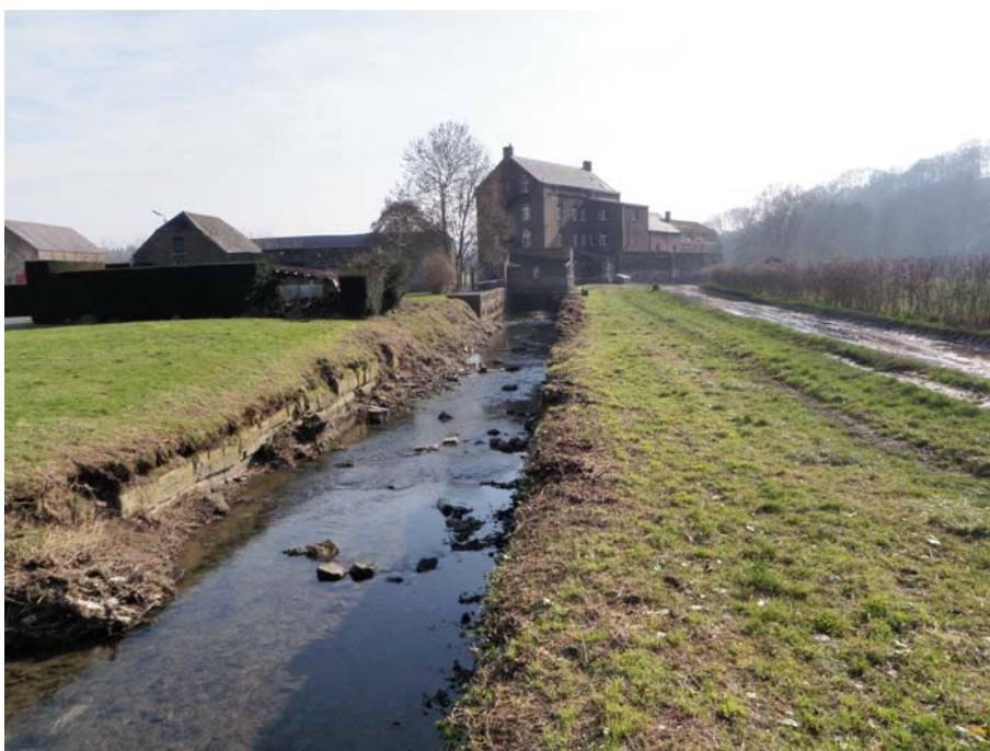
Figure 47. Vue vers l'aval du canal d'amenée non alimenté par la Méhaigne pendant la période de construction de la centrale hydroélectrique du Val Notre-Dame.
