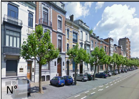
Maison 2 façades en ville
