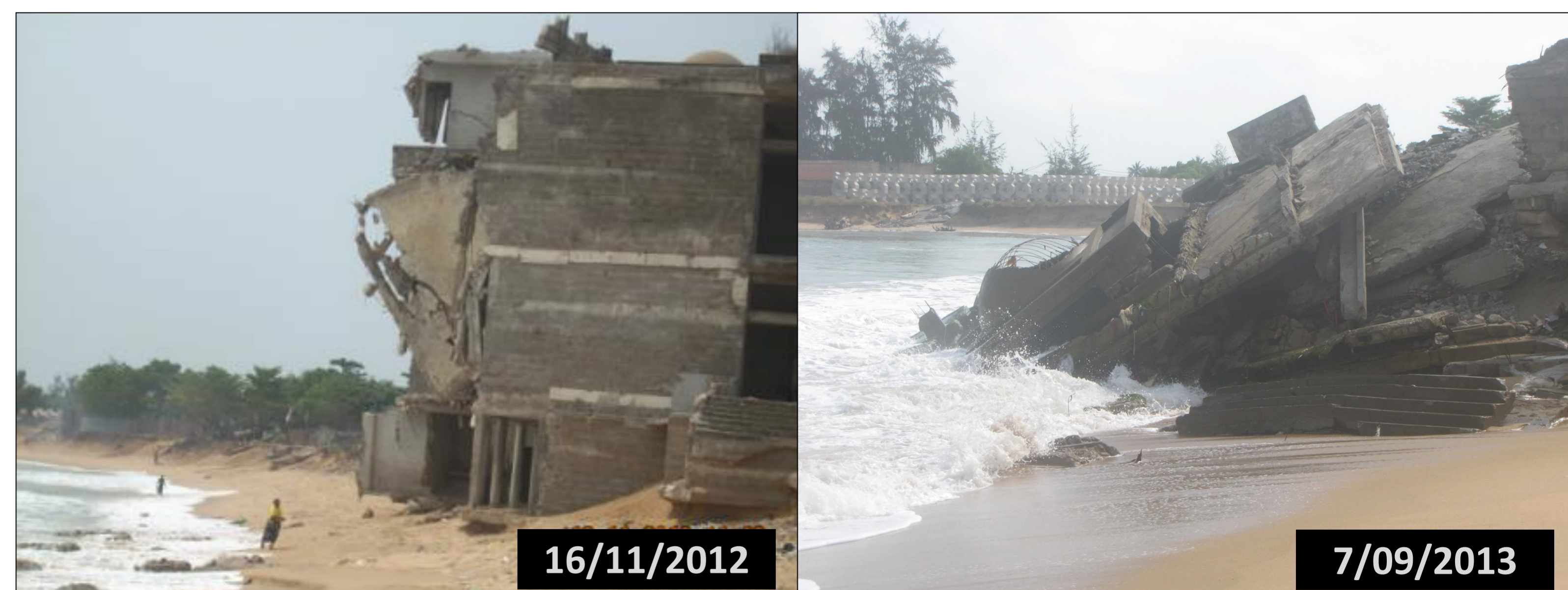
Figure 2: Illustration du recul de la plage et de la destruction de bâtiments à l'est de Cotonou. Ici, la même construction à 10 mois d'intervalle. Ce bâtiment (positionné par une étoile sur la Fig. 1) actuellement détruit se trouvait à 100 m de la plage en 2002 (Clichés: Y.C. Hountondji, 2012; P. Ozer, 2013).
