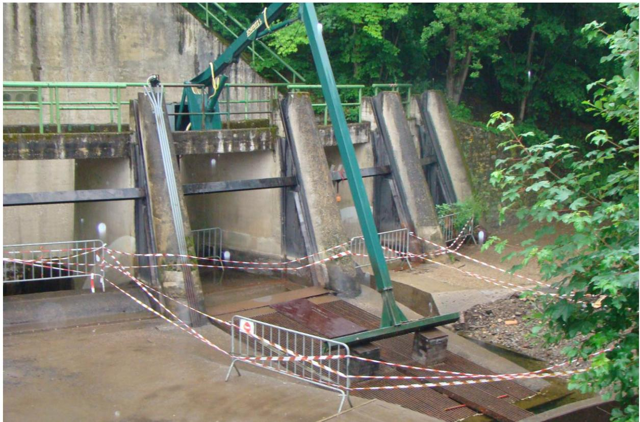
Figure 6 : Prise d'eau de la CHE de Coo-dérivation lorsque le canal d'amenée a été mis à sec en juin 2013
