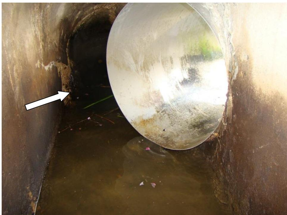
Figure 14 : Partie terminale de l'exutoire de dévalaison du barrage de Lorcé, présentant une zone en retrait où la flèche blanche représente la zone d'accumulation
