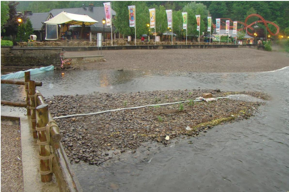
Figure 34 : Photo du chenal de restitution court-circuité de la CHE de Coo-dérivation lors de travaux de maintenance en juin 2013 empêchant l'accès aux poissons lors de leur recherche d'une voie de passage
