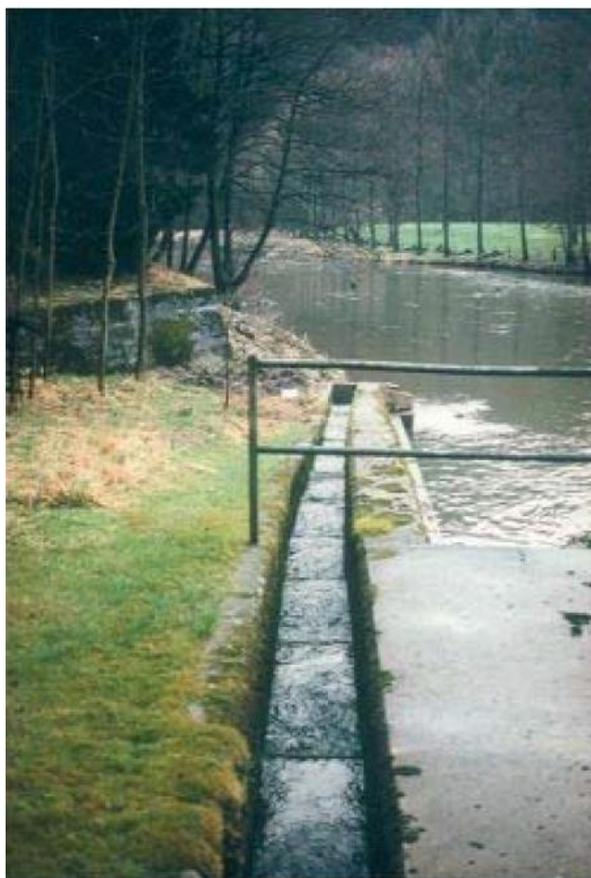
Figure 9 : Vue aval de l'ancienne échelle à poissons installée au barrage de Lorcé (Amblève) entre 1932 et 2007
