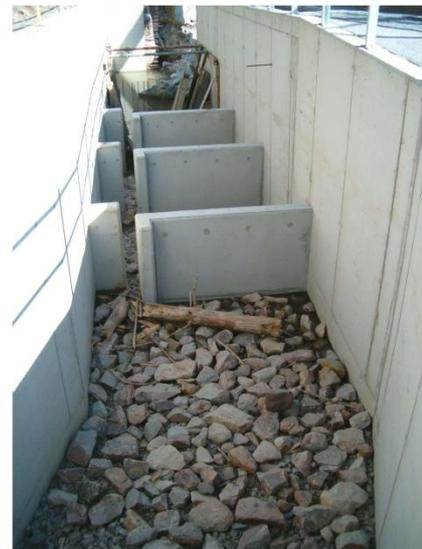
**Figure 3 : Vue aval du barrage de Lorcé lors de la construction de la nouvelle échelle à poissons en rive gauche (à gauche) et une photo de la nouvelle échelle à poissons du barrage de Lorcé avec la présence d'un substrat rocailleux (à droite)**
