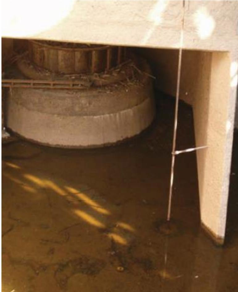
Figure 13 : Turbine FRANCIS de 3m<sup>3</sup>/s installée au barrage de Lorcé (Amblève), l'eau du débit réservé y est turbinée.
