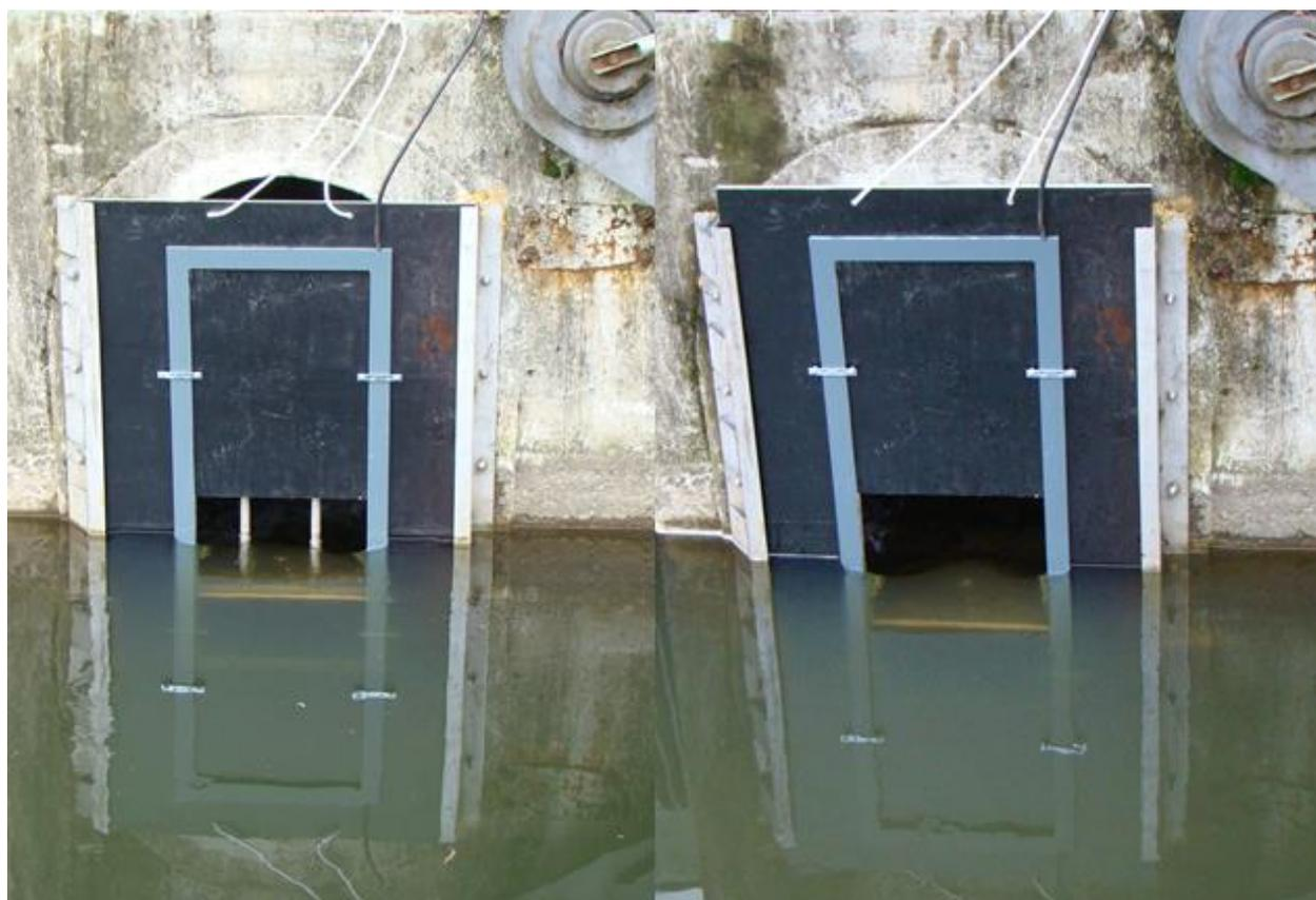
Figure 16 : Configuration de l'entrée de l'exutoire de dévalaison du barrage de Lorcé : avec la grille (à gauche) et sans la grille (à droite)
