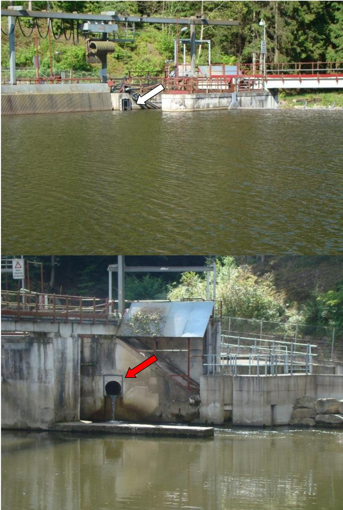
Figure 5 : Entrée amont (flèche blanche) de l'exutoire (en haut) et sortie (flèche rouge) aval de l'exutoire (en bas) aménagé au barrage de Lorcé.
