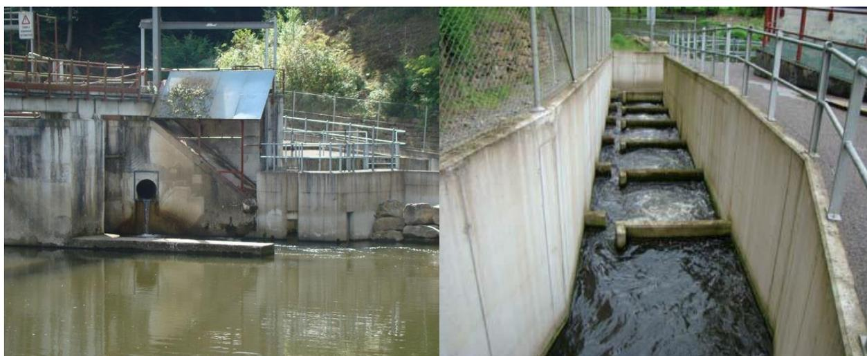
Figure 5 : Vue aval du barrage de Lorcé où l'on voit l'entrée de la nouvelle échelle à poissons (à partir de 2007) en rive gauche (à gauche) et une photo de la nouvelle échelle à poissons du barrage de Lorcé (à droite)
