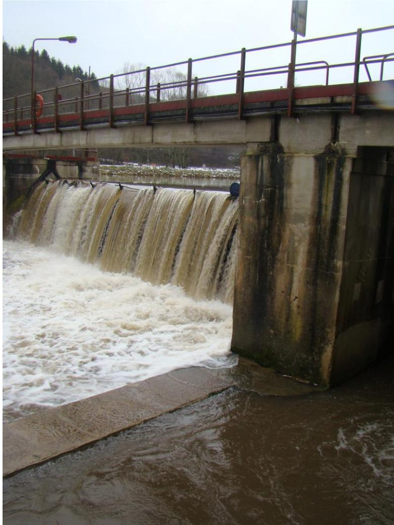
Figure 22 : Photo du barrage de Lorcé lorsque la vanne 2 est légèrement abaissée et laisse passer un filet d'eau
