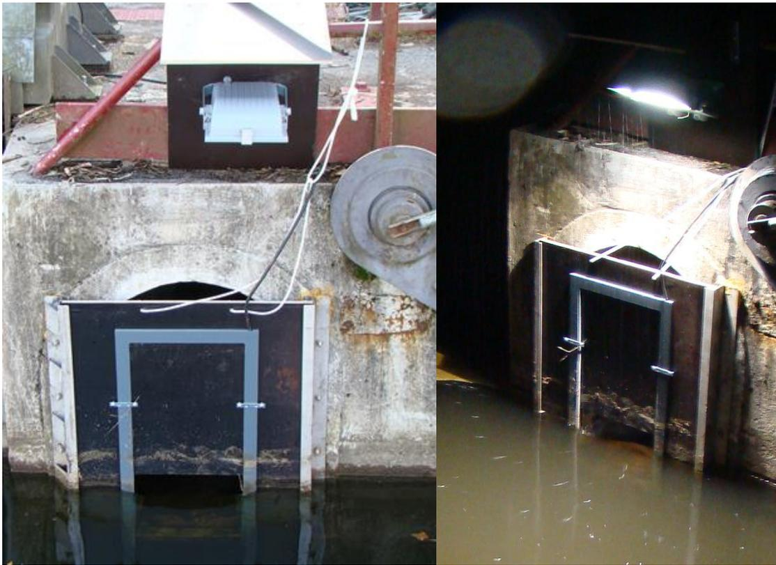
Figure 17 : Entrée de l'exutoire de dévalaison avec la présence d'une lampe au mercure, de jour à gauche et de nuit à droite
