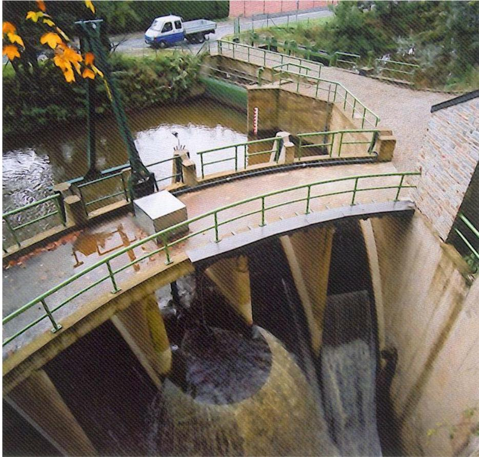
Figure 7 : Vue aval de la prise d'eau de la CHE de Coo-dérivation avec les 7m de chutes d'eau en surverse
