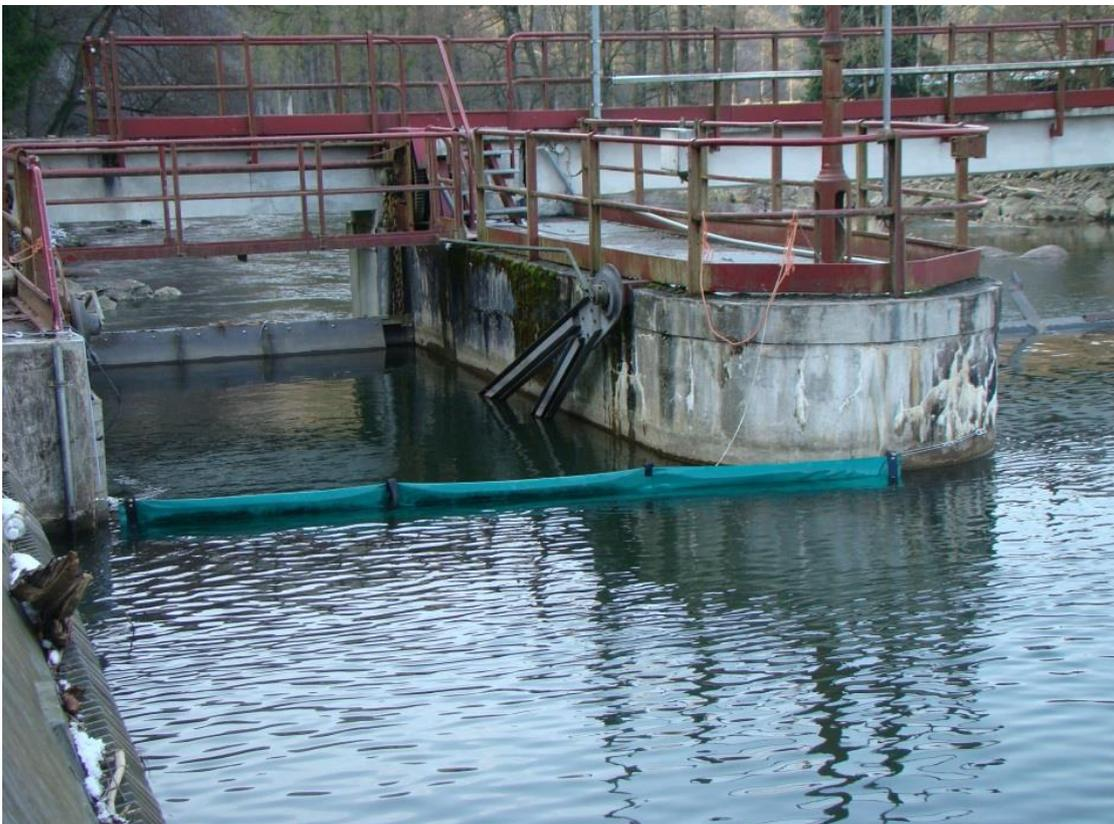
Figure 18 : Présence de la drome juste en amont de l'entrée de l'exutoire de dévalaison du barrage de Lorcé
