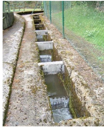
**Figure 2 : Vue aval du barrage de Lorcé où l'on voit l'entrée de l'ancienne échelle à poissons (1932 à 2007) en rive gauche (à gauche) et une photo de l'ancienne échelle à poissons du barrage de Lorcé (à droite)**
