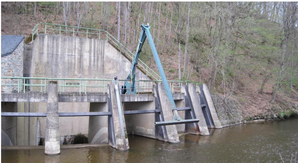
Figure 26 : Fin du canal de dérivation. En dessous du dégrilleur se trouvent les grilles menant aux turbines de la prise d'eau de la centrale électrique de Coo dérivation (27/04/2012)
