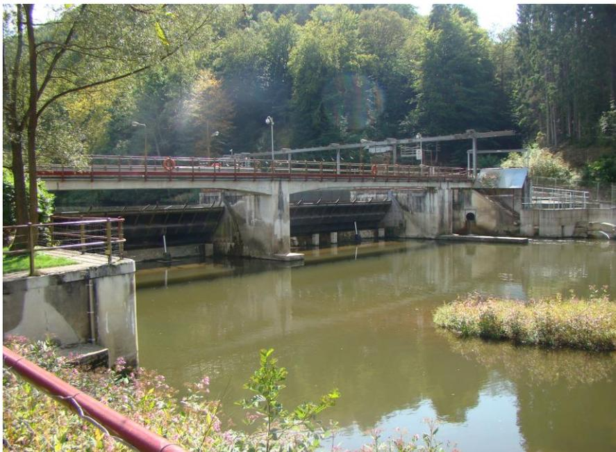
Figure 21 : Vue aval du barrage de Lorcé (Amblève) muni de deux vannes mobiles
