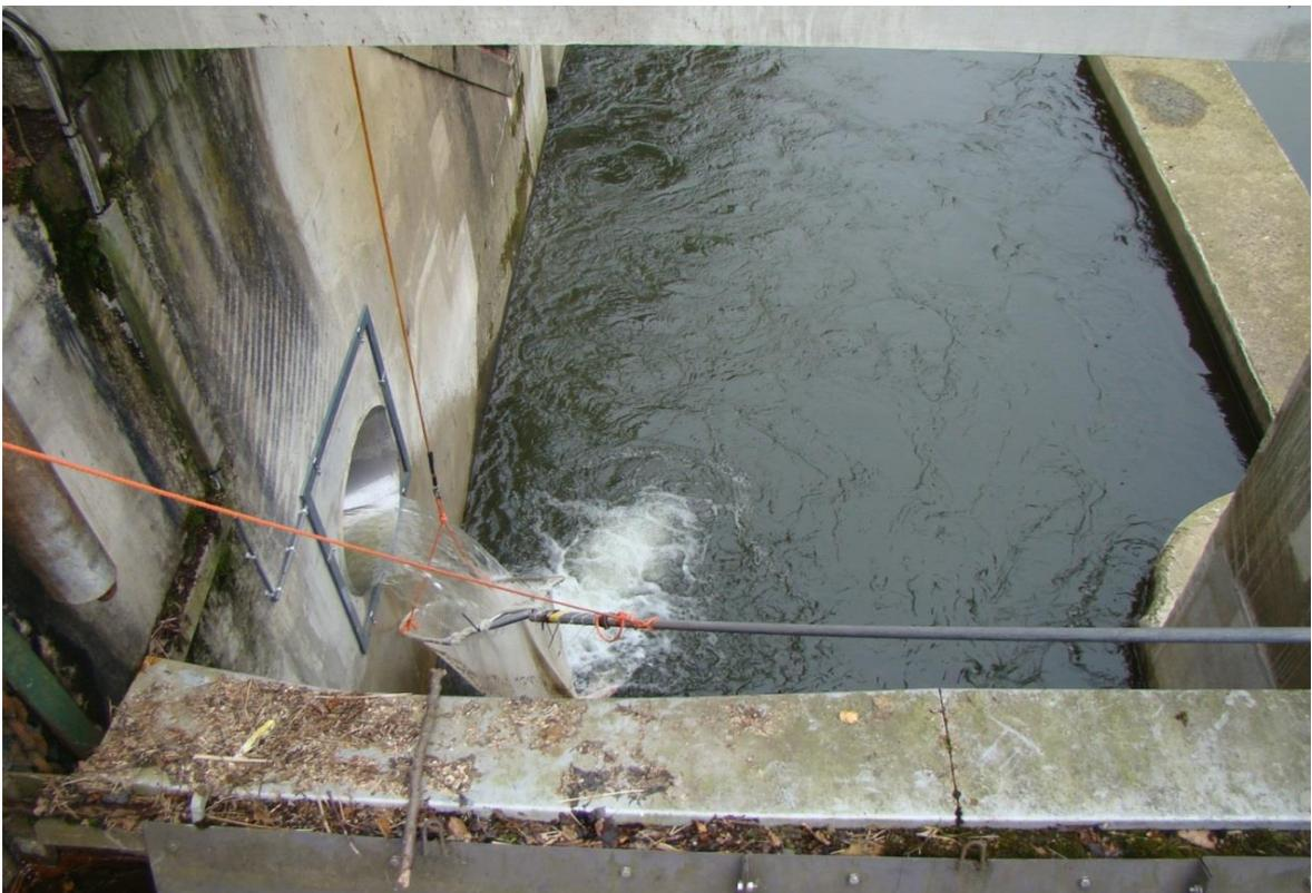
Figure 12 : filet provisoire installé au niveau du rejet de l'exutoire du barrage de Lorcé
