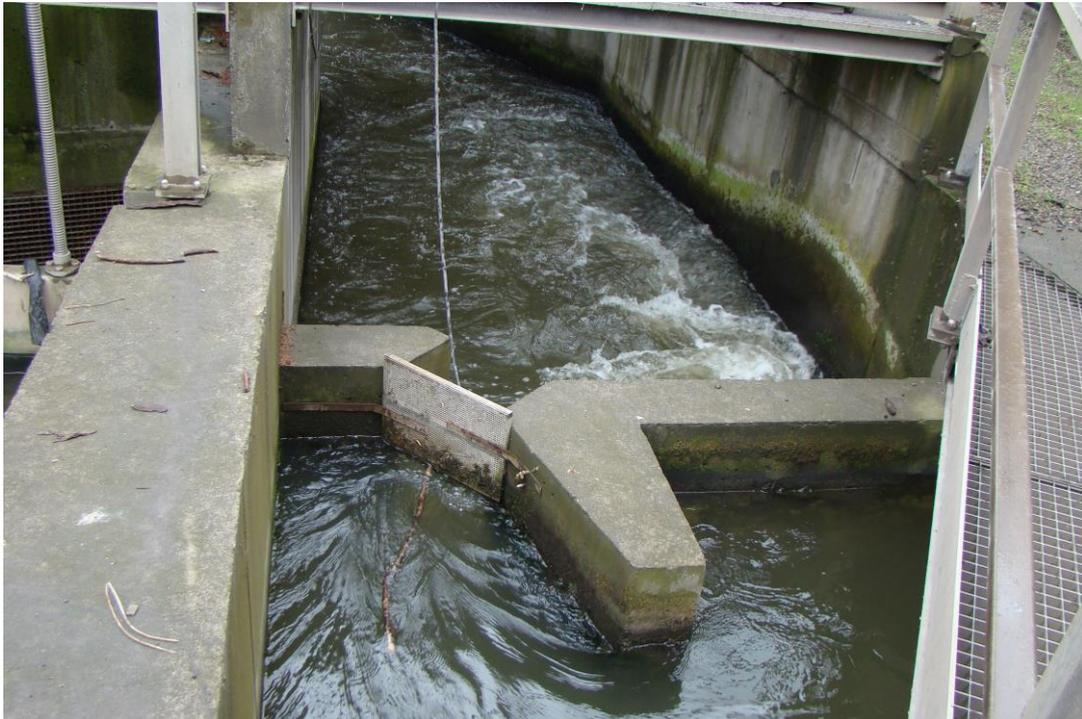
**Figure 10 : Antenne CIPAM installée au niveau de l'échelle à poissons de Monsin sur la Meuse**
