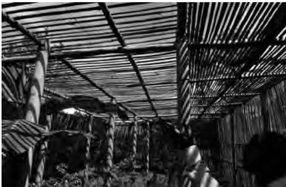
Ombrière en matériaux naturels installée par REAFOR, projet FAO financé par l'Union Européenne.
