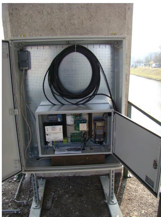
Figure 6. Au-dessus : antenne de détection CIPAM placée en 2012 au niveau d'une échancrure à l'amont de l'échelle à poissons du barrage des Grosses Battes sur la basse Ourthe à Liège. En dessous : station d'enregistrement des données logée dans une armoire métallique spécialement installée sur la pile du barrage mobile.
