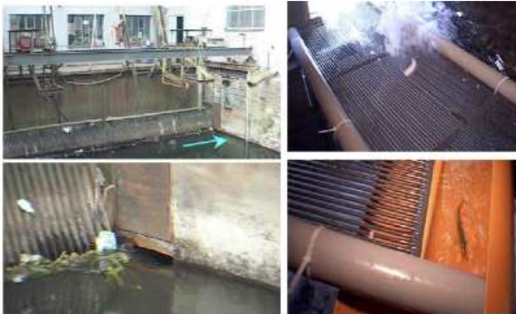
Figure 2 a. Vues (à gauche) de l'exutoire de dévalaison latéral (débit : 0,1-0,2 m 3 /s ; vitesse : 1-1,2 m 3 /s) aménagé dans le prolongement latéral de la grille de la prise d'eau de la centrale hydroélectrique Merytherm (10 m 3 /s maximum) sur l'Ourthe et (à droite) du système de récupération des poissons.
