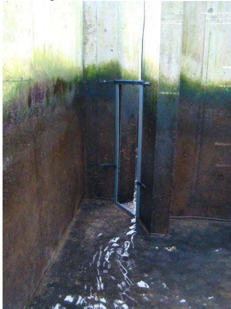
Figure 4. Antenne de détection cipam placée en 2012 au niveau d'une échancrure à l'amont de l'échelle à poissons du barrage des Grosses Battes sur la basse Ourthe à Liège
