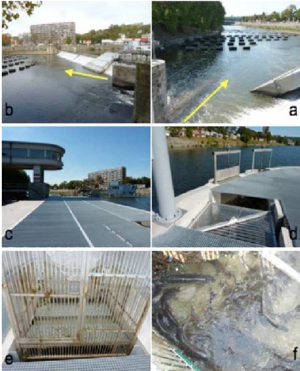
Figure 2. Quelques vues de l'échelle à poissons des Grosses Battes sur l'Ourthe à Liège (a-b) : vues vers l'aval montrant le flux d'eau de sortie de l'échelle avec à proximité le rejet d'eau de la centrale hydroélectrique flottante OMEGA ; (c) : vue vers l'aval montrant l'échelle recouverte d'une protection en caillebotis ; (d) : prise d'eau à l'amont de l'échelle et cage de capture en position ; (e) : cage de capture soulevée montrant en arrière-plan l'ouverture du cône d'entrée ; (f) relevage de la cage et des poissons piégés.
