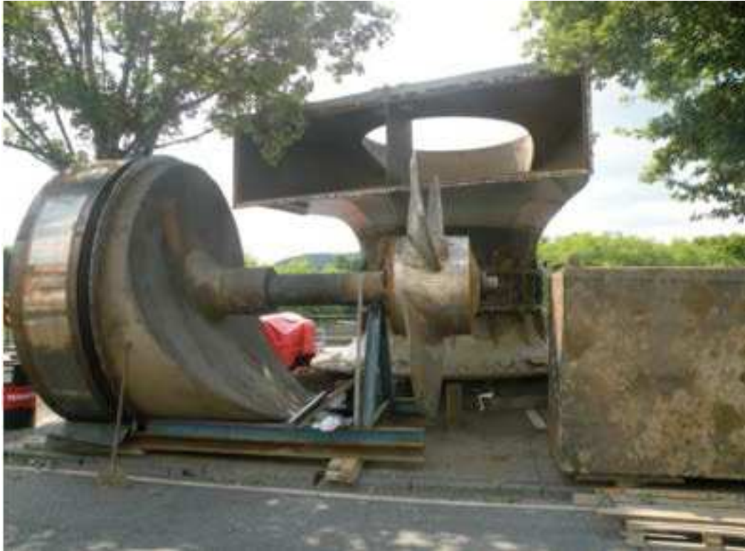
Figure 3. Démantèlement au cours de l'été 2012 de la turbine flottante en siphon installée sur l'Ourthe au barrage des Grosses Battes en 2005 et emportée par la crue de fin 2010 (photo J. Delcour, Biologie du Comportement, ULg).
