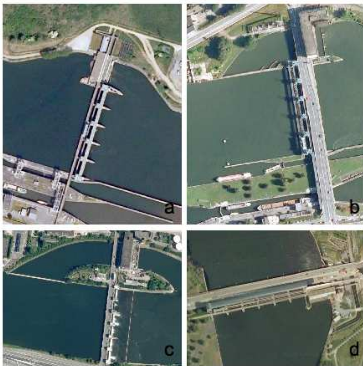
Figure 2. Vues aériennes (Google map) des sites des barrages+centrales hydroélectriques d'Apsin-Neuville (a), Yvoz-Ramet (b), Monsin-Liège (c) et Lixhe -Visé (d) sur la Meuse liégeoise.
