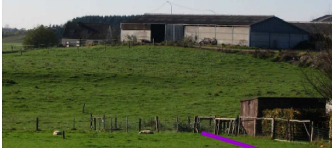
Ferme rue de la gare à Habay
