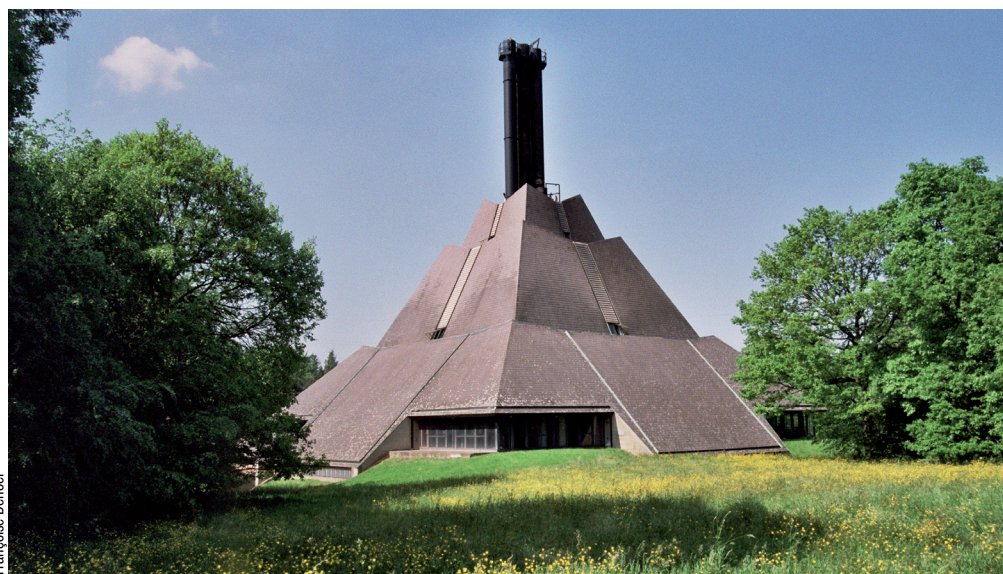
La centrale de cogénération au Sart-Tilman fait économiser 8000 tonnes de CO 2 par an.
