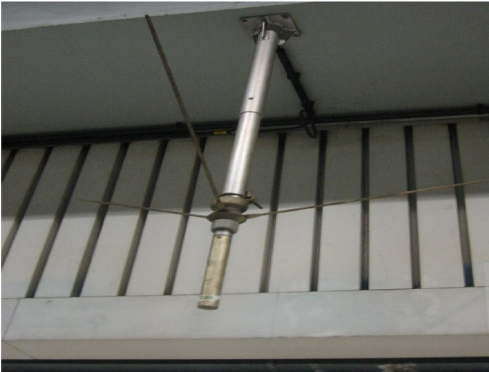
FIGURE 11.3. – Antenne GSM (station de métro Rogier, Bruxelles).
