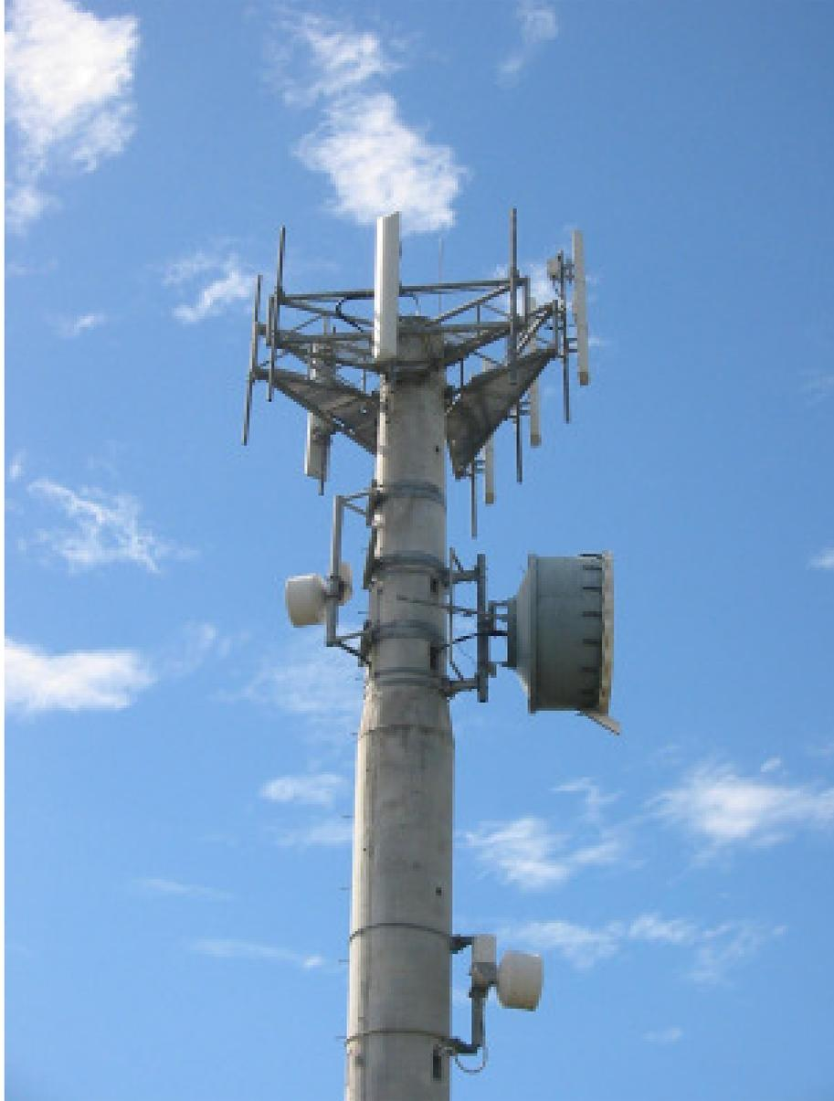
FIGURE 10.10. – Exemple d'antennes GSM et paraboliques (ROCKHAMPTON, QUEENSLAND, AUSTRALIE).
