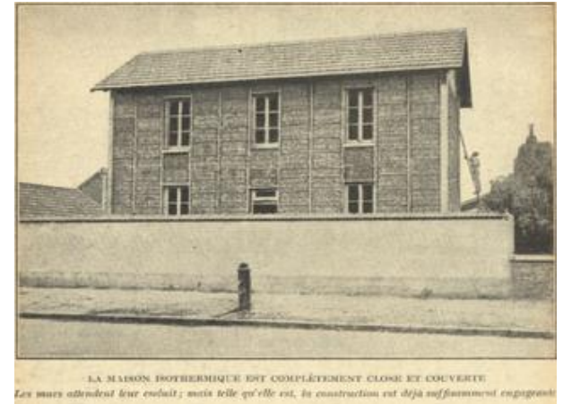
Maison Feuillette en construction ( Science et Vie n°56, 1921) (site des Compailions)
