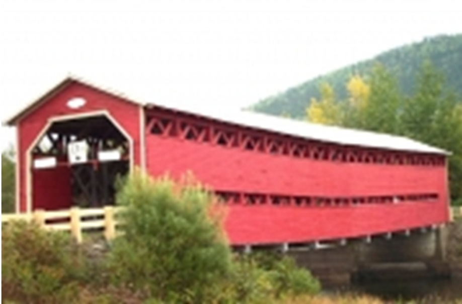
Pont couvert de Hartlund, NB, Canada
