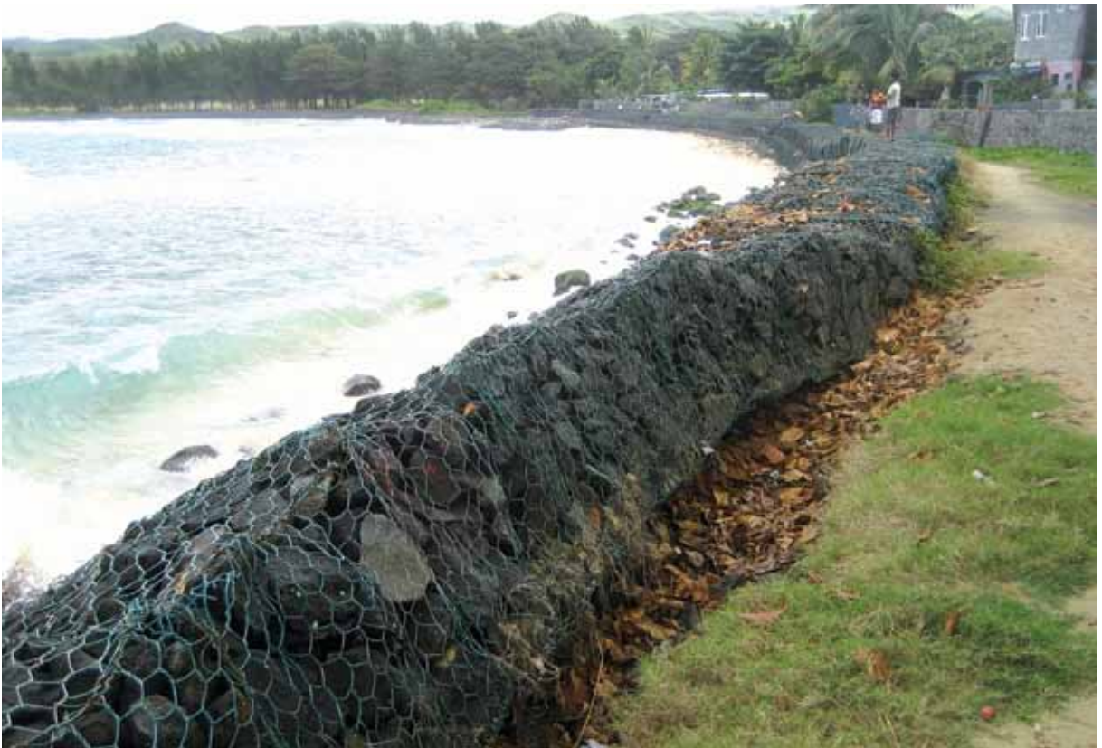
Gabions on the beach of Rivière des Galets
