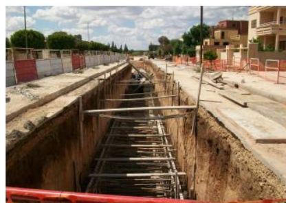
Construction d'un délesteur
