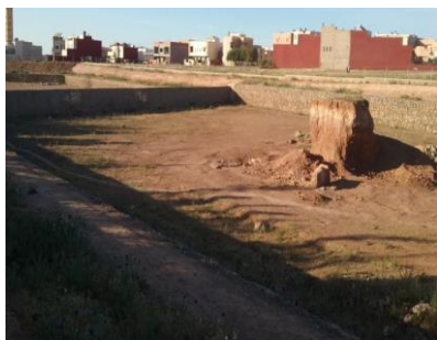
Bassin de rétention
