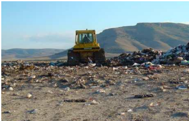
Site du CET
