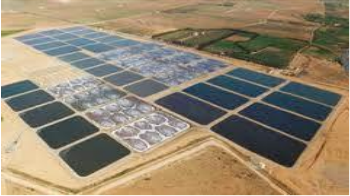
Photo aérienne de la station de lagunage d'Oujda
