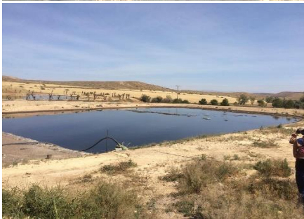
Bassin de lixiviat
