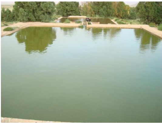
Bassin aérobie de la STEP de Figuig
