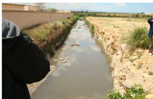
Photo 5 : Canal de drainage des eaux à Oujda
