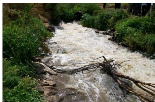
Photo 6 : Principal émissaire des eaux usées de Oujda
