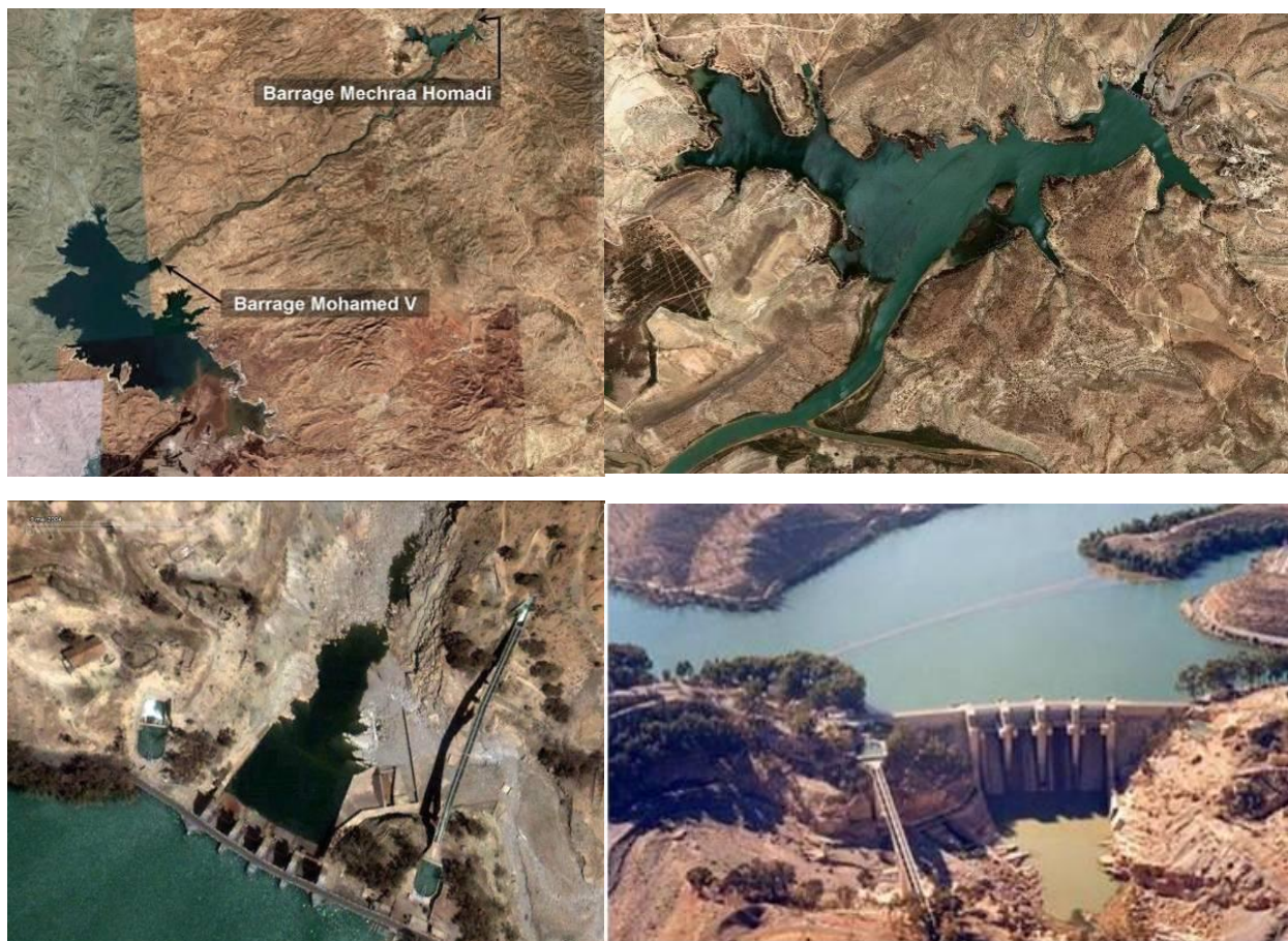
Vues aériennes du barrage de Mechra Homadi
