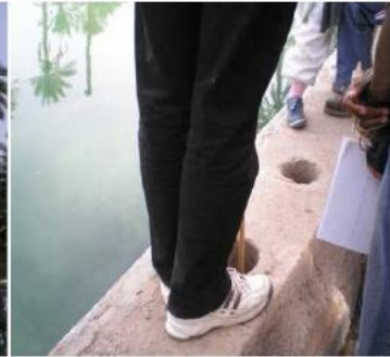
Système de réglage de débit
