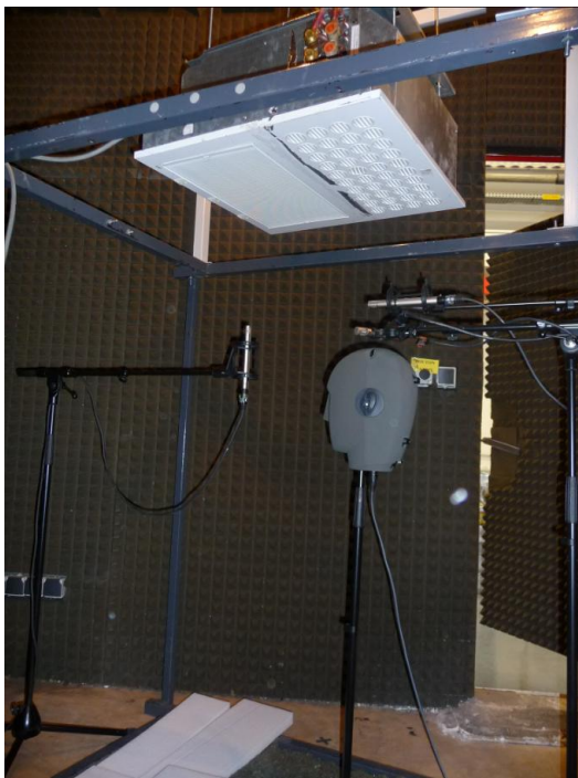
FIGURE 4.9 – Photo de l'installation pour l'enregistrement du son du système CST1 (voir tableau D.1 en annexe).
