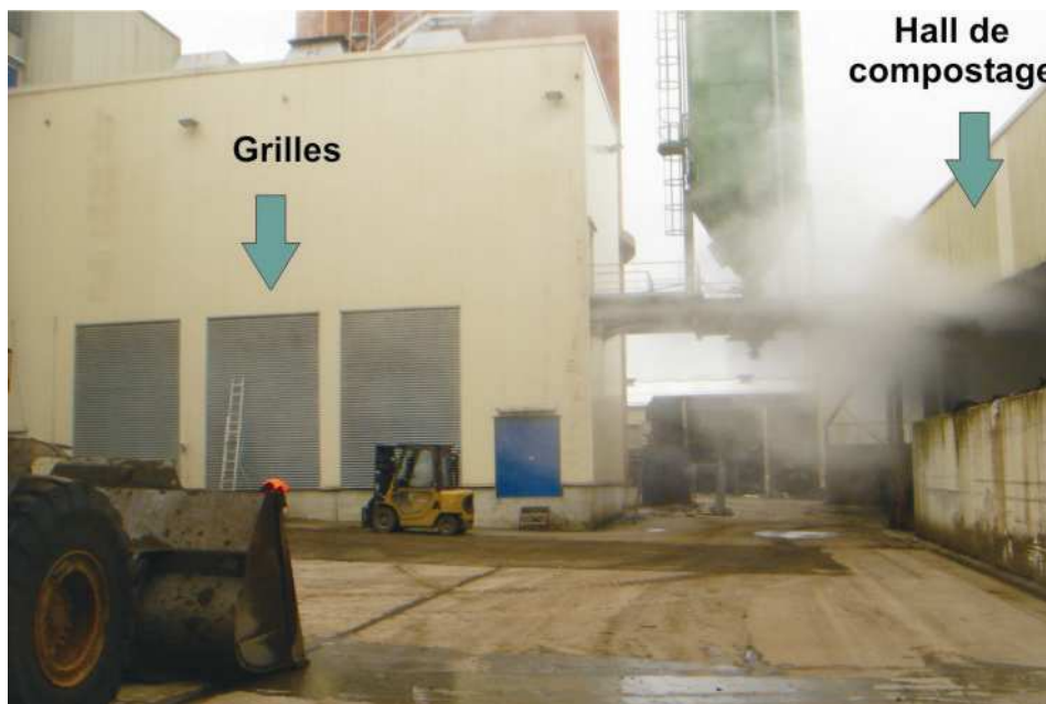
Figure 7 : Grilles d'aspiration de l'air du sécheur de boues
