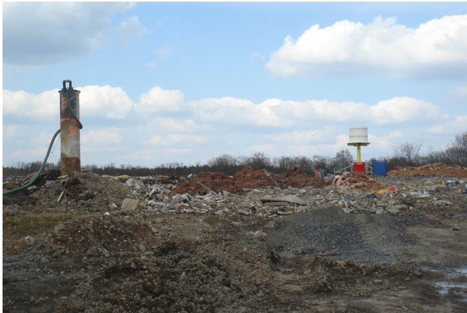
Figure 1 : Dégazement d'un puits de dégazage
