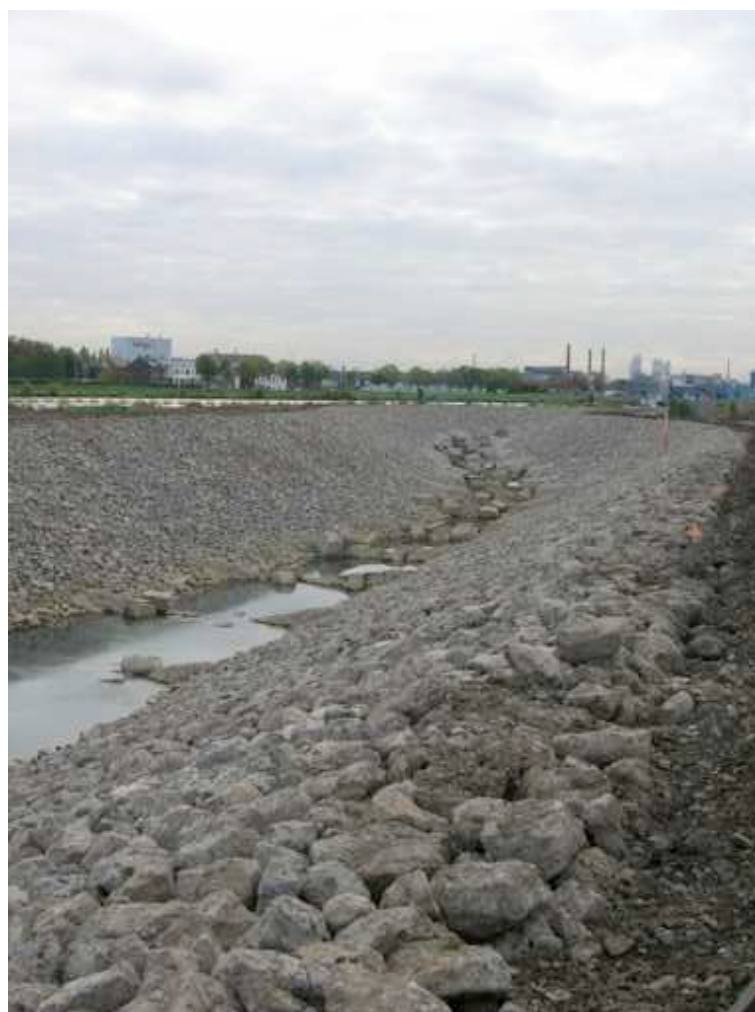
Photos 13/3 . Vue de l'état d'avancement de la construction de la nouvelle échelle à poissons (rivière de contournement) du barrage de Borgharen-Maastricht sur la Meuse aux Pays-Bas. Au-dessus: sortie en aval du barrage. En-dessous : bras de contournement en rive gaauche de la Meuse ((photos A. Gillet , MET)
