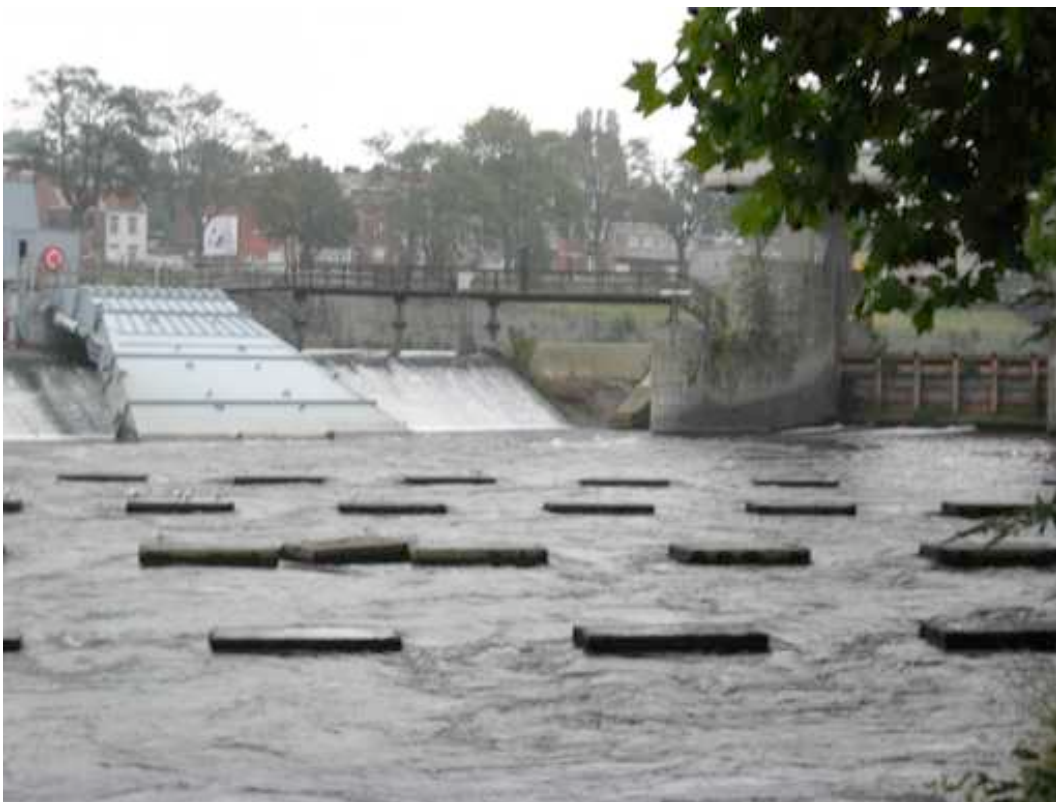
Photo 9/5. Vue de l'écoulement de l'eau au barrage des Grosses Battes au moment de la dévalaison de la truite TM1/07 radio-pistée vers le 11/09. Débit à Angleur de 31,0 m 3 /s.
