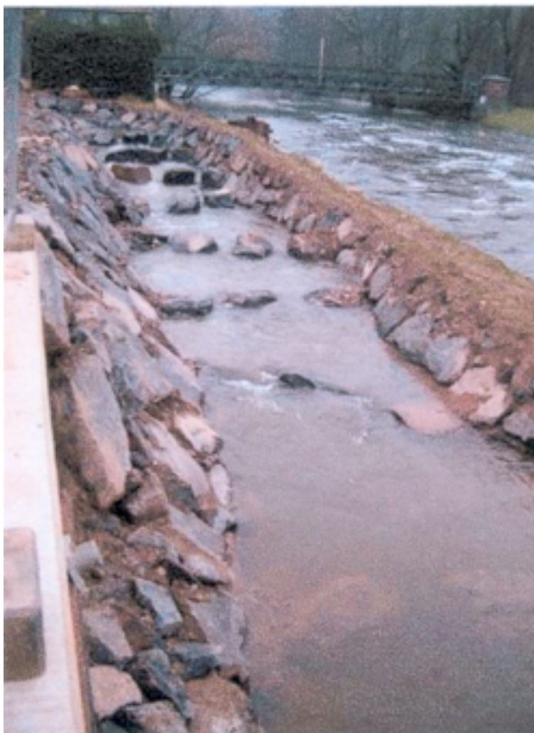
Photo 13/6. Nouvelle passe à poissons (inauguration le 13 décembre 2007) construite au barrage du lac-réservoir d'Obermaubach (dénivellation de 9 m) sur la Rur en Allemagne (source : http://www.sportvisserij nederland.nl/nieuws_en_media/Default.aspx?ids=672&idp=712&id=2186&taal=nl-Nl ).
