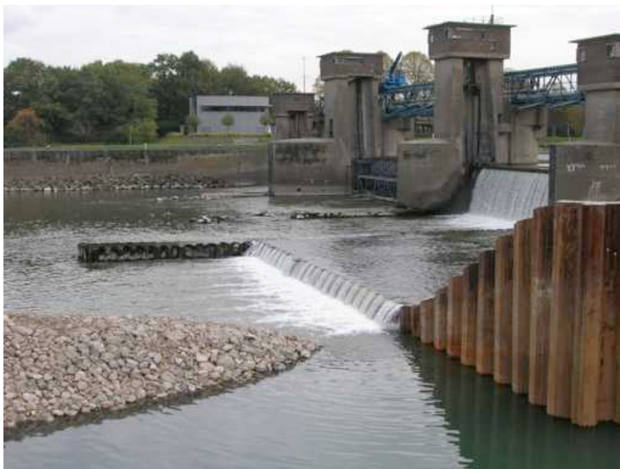
Photos 13/3 . Vue de l'état d'avancement de la construction de la nouvelle échelle à poissons (rivière de contournement) du barrage de Borgharen-Maastricht sur la Meuse aux Pays-Bas. Au-dessus: sortie en aval du barrage. En-dessous : bras de contournement en rive gaauche de la Meuse ((photos A. Gillet , MET)
