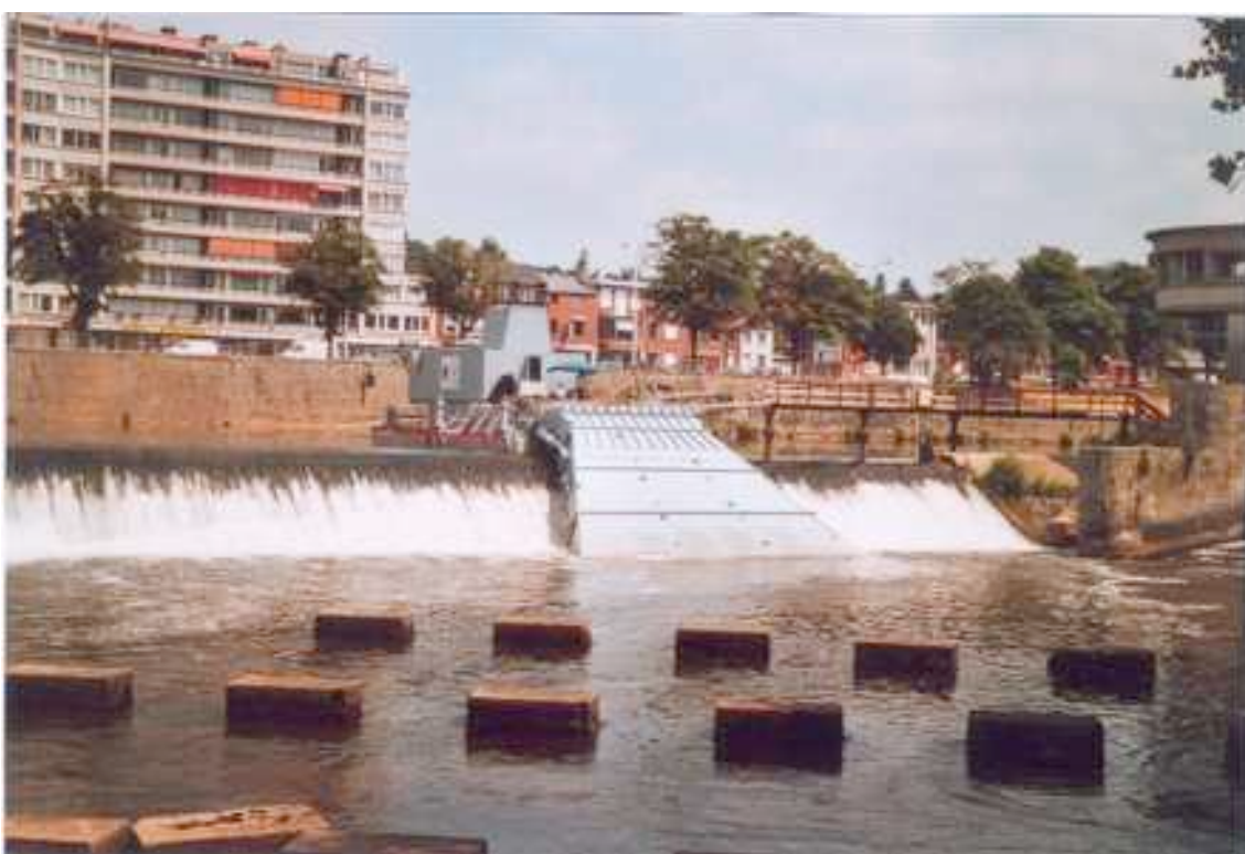
Photos 13/4. Vue du barrage des Grosses Battes sur la basse Ourthe à Angleur montrant la position de la nouvelle centrale hydro-électrique flottante (au-dessus) par rapport à l'ancienne centrale en rive droite et (en-dessous) par rapport à l'échelle à poissons Denil à l'emplacement de laquelle sera construite la nouvelle échelle à bassins.
