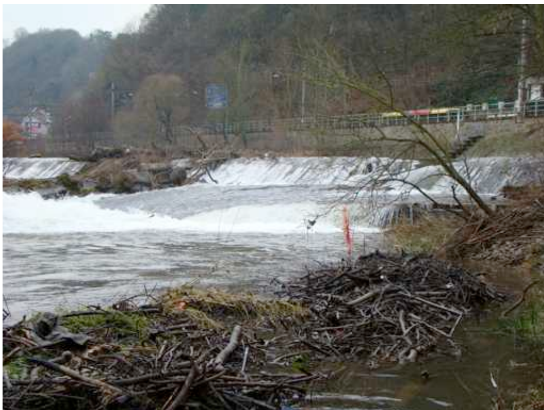
Photo 9/7. Le double seuil difficile à franchir du barrage fixe de Tilff dans les conditions de débit de fin 2007.
