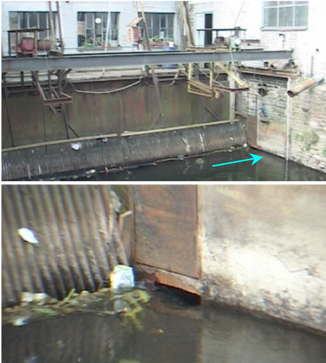
Photo 4/3. A (au-dessus). Vue de la grille de la prise d'eau vers les turbines et, dans l'angle du mur et de la grille (flèche), l'emplacement de l'exutoire de dévalaison (B en-dessous) qui débouche dans le tunnel (extrait du film de présentation de ProFish Technology).
