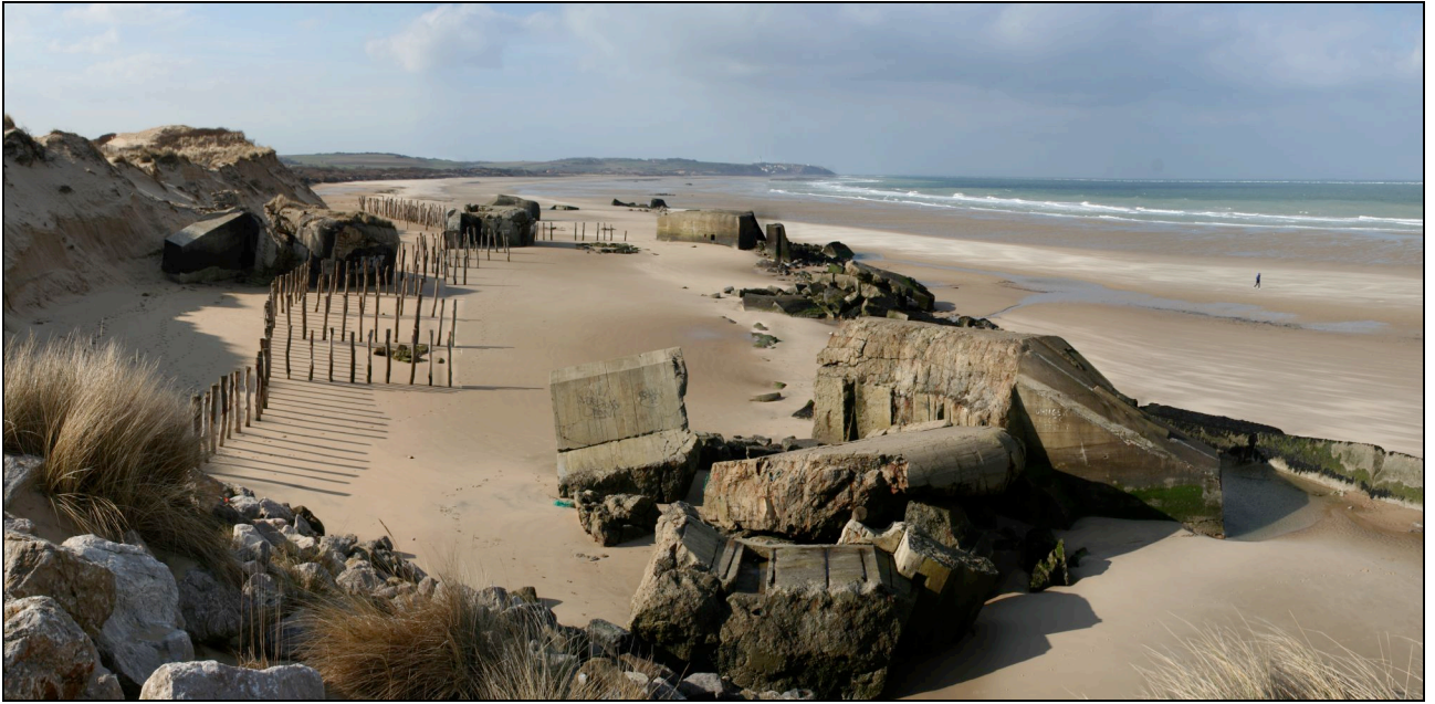
Ici, l'érosion du cordon de dunes sur lequel étaient construits ces blockhaus du mur de l'Atlantique a provoqué l'effondrement de ceux-ci. Leur masse a cependant permis qu'ils restent sur place.
