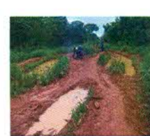
Fig. 6. Déliquescence des infrastructures routières
