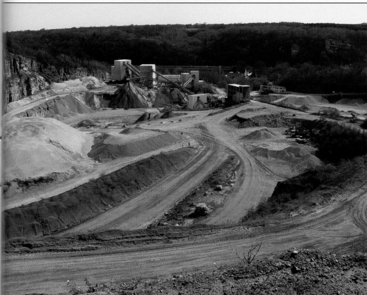
Vue sur le niveau technique de la carrière de Beez le 2 avril 2011. Photo. : M. Blondieau.
