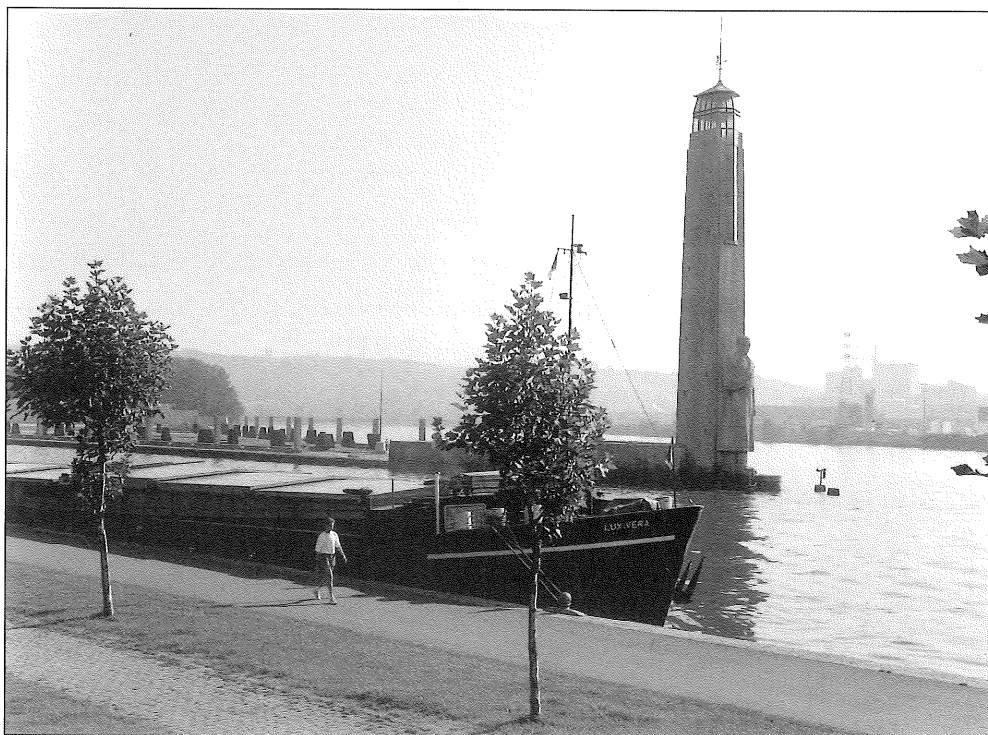
12. Entrée du canal Albert au niveau de l'«île Monsin». Cette entrée est également visible sur l'illustration 11.
