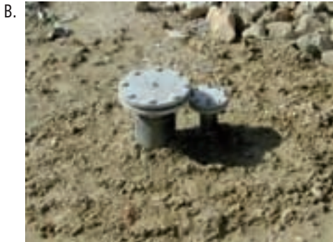
Schéma de construction d'un puits de dégazage (A), tête de puits définitive non raccordée (B) et provisoire (C).
