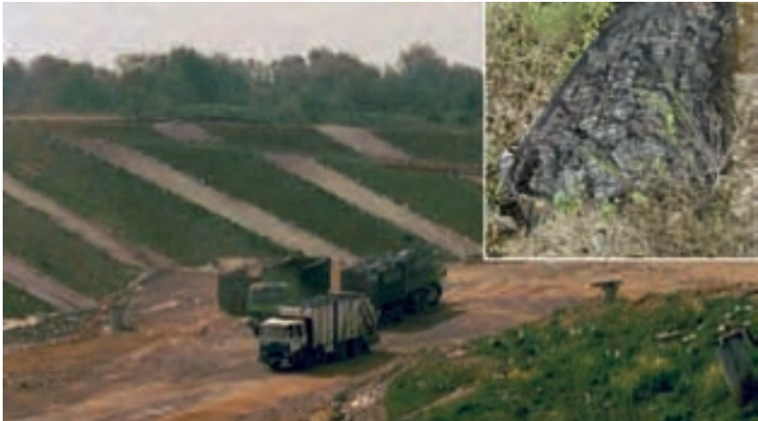
Systèmes de drainage des liquides et des gaz sur les flancs du CET.
