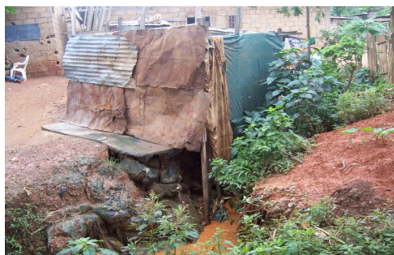
Figure 4 : Latrine à canon sur l'Abiergué
