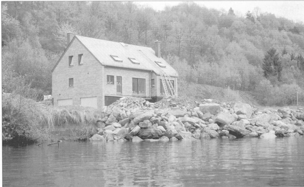
Photo 10 - Anseremme, 1996, Meuse : enrochement au droit d'une maison récemment construite en zone inondable. - Riprap at the foot of a house recently built in a regularly flooded area.
