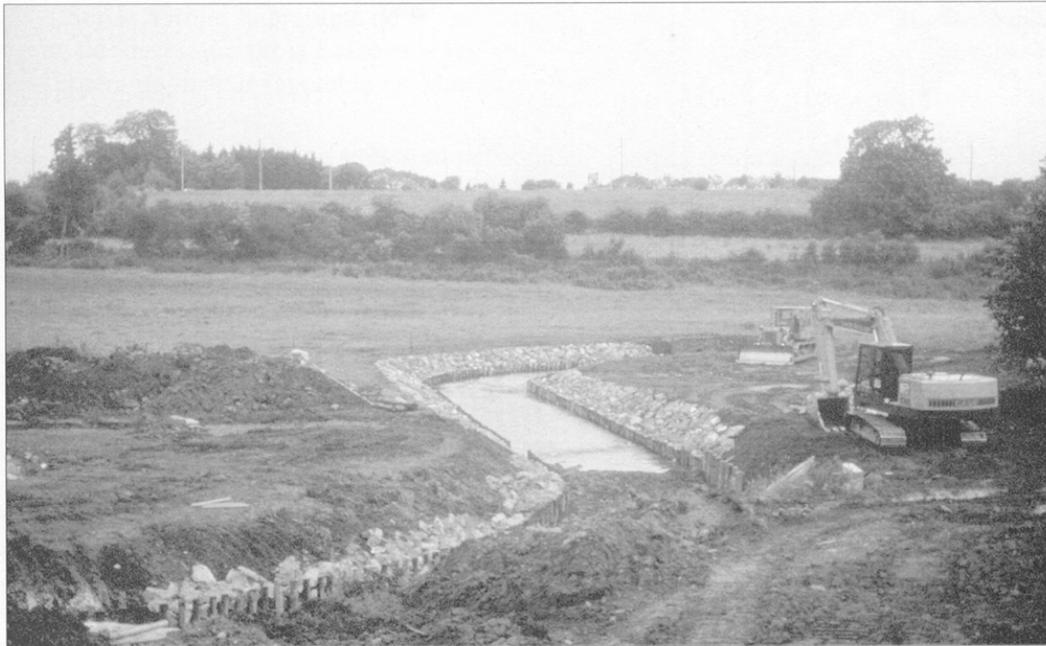
Photo 7 - Virelles, 1989, Eau Blanche : enrochements au voisinage de la station d'épuration, réalisés par les Services techniques provinciaux. - Consolidation works near by a sewage station.
