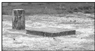
Dalle en ciment fermant définitivement l'ouverture laissée pour le comblement des vides pouvant résulter du tassement des matières de remblayage. Batterie – puits n° 2.
